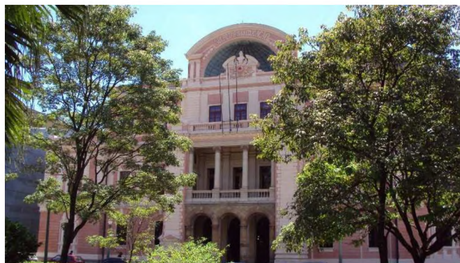
Figura 3 – Antiga Secretaria do Interior, praça da Liberdade, Belo Horizonte. No frontão, a cúpula em meia-esfera de interior azul, acolhe e dá um destaque celeste ao busto feminino da República. Fotografia: Ricardo Giannetti.
