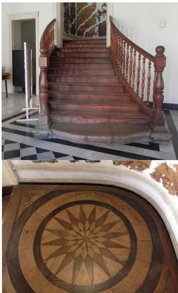
Figura 9: Palácio dos Azulejos – Vestíbulo. Detalhes da escada e do piso de marchetaria no patamar da escada. Fonte: Thaina Isabela Silva. PUC Campinas.
