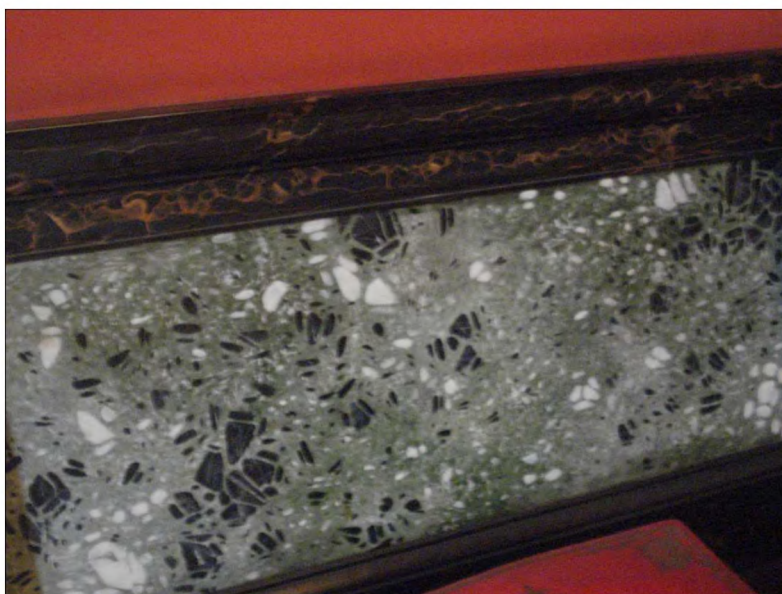
Figura 14 – Detalhe de marmoreado que imita o granito, realizado em parede do Palácio de Nova Friburgo, no Rio de Janeiro. Fonte: Acervo de Carlos Alberto Santos, s/d.
