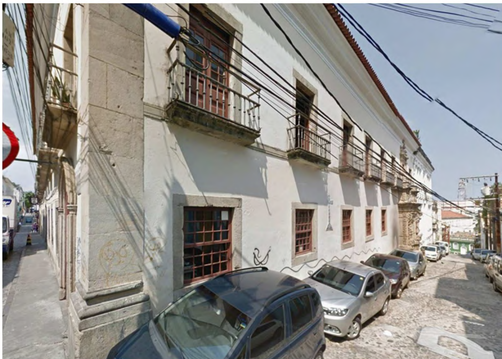
Figura 6: Fachada pela rua Guedes de Brito. Fonte: (GOOGLE, 2017).
