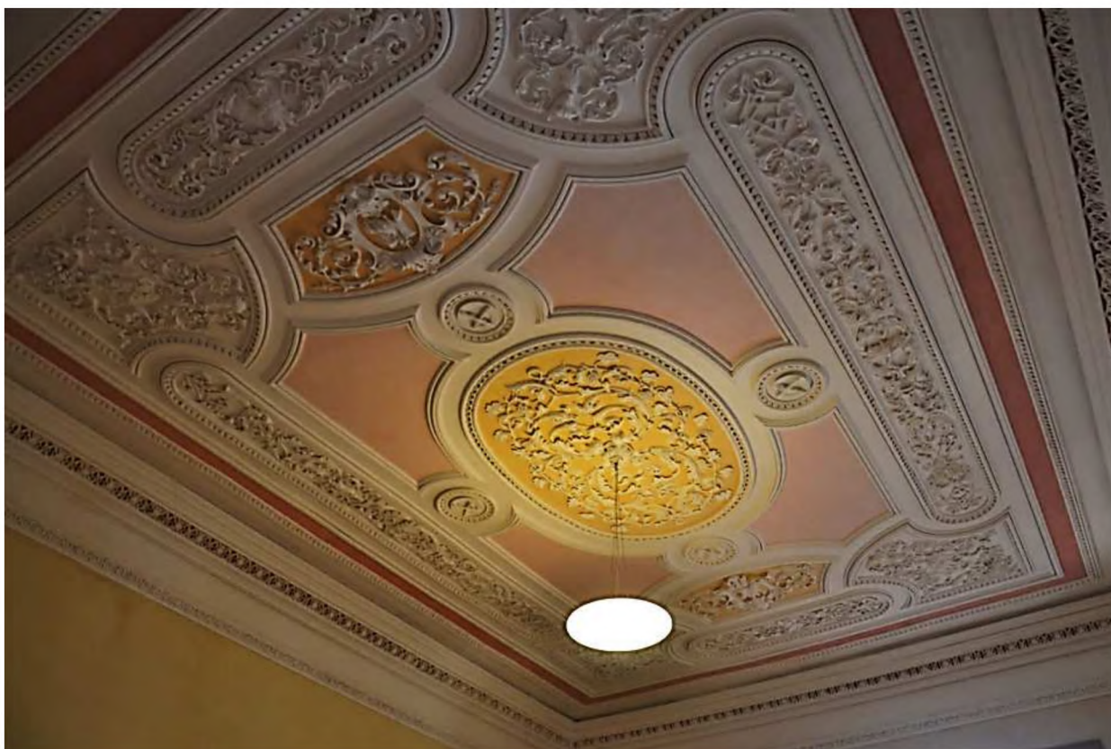
Figura 3 – Vista geral forro de estuque decorado em relevo, na sala de jantar da antiga residência do Conselheiro Maciel (1878), Pelotas, RS. Fonte: foto de Alexandre Mascarenhas, 2013.
