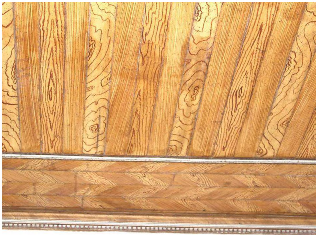
Figura 15: Detalhe do forro da sala de jantar. Fonte: Acervo da autora
