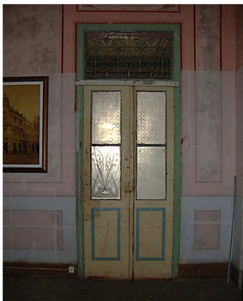
Figura 7: Porta interna do solar, com uma de suas folhas de vidro jateado original. Fonte: Própria dos autores.
