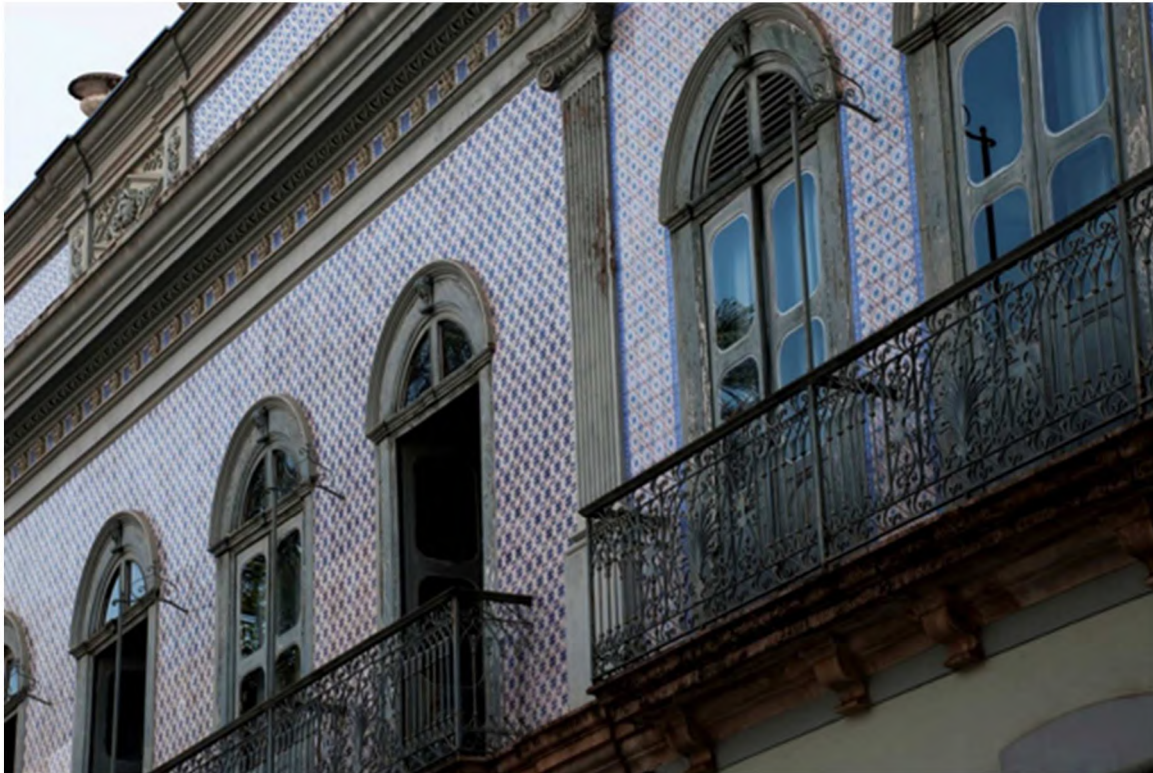
Figura 18 : Sobrado do Barão de Itatiba. Detalhe do revestimento da fachada com azulejos. Fonte: < http://iabcampinas.org.br/identidade-arquitetonica/palacio-dos-azulejos/ > Acesso em maio de 2017.
