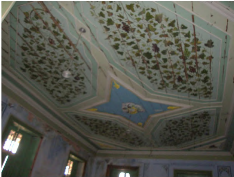
Figura 10: Detalhe do forro da sala de refeição. Fonte: acervo próprio dos autores
