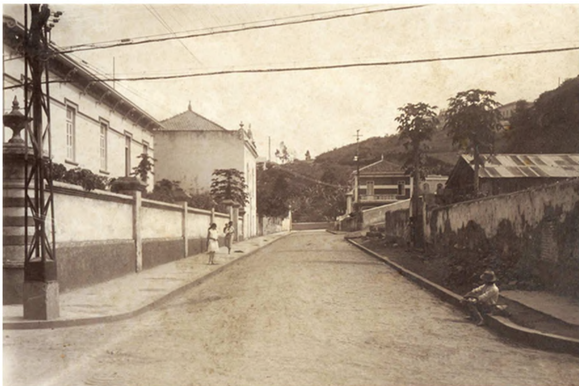
Fig. 4 – Fachada Rua Vasco Coutinho -Fonte: Arquivo Público do Município de Vitória, 2016
