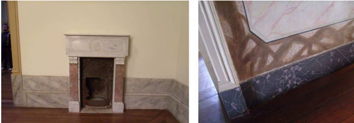
Figura 16 – (E) Marmoreado executado no rodapé de uma sala do casarão do Conselheiro Maciel. (D) A mesma técnica no rodapé do hall da escada do sobrado que pertenceu ao Barão de Butuí. Fonte: Fotos do autor, 2015.
