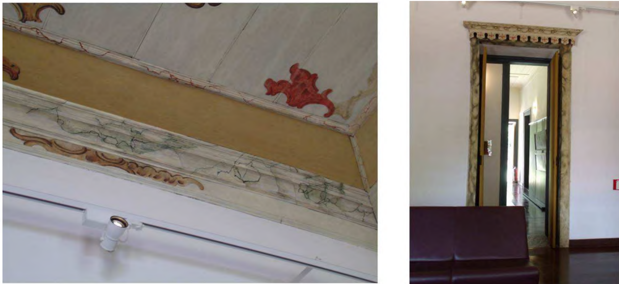
Figura 17 – Detalhes do marmoreado no rodaforno e na ombreira de porta do museu Casa do Padre Toledo, na cidade de Tiradentes, em Minas Gerais. Fonte: Fotos do autor, 2014.
