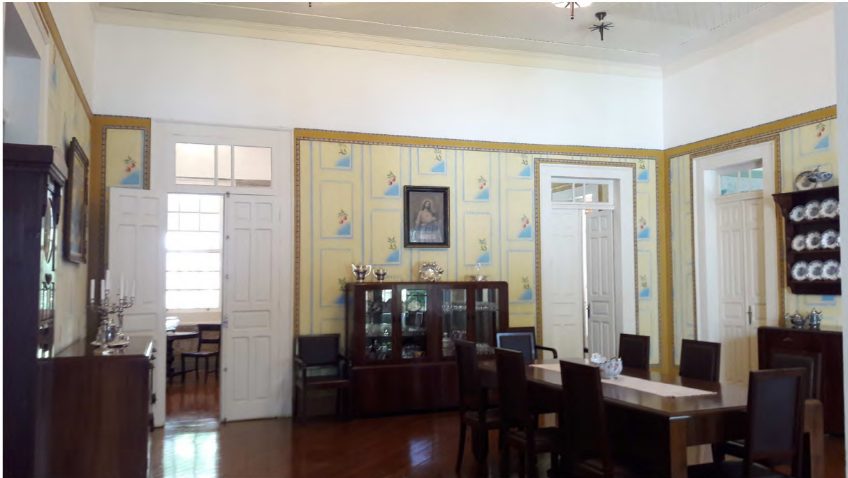
Figura 16: Sala da família, hoje sala de jantar da casa sede. Portas com bandeira em vidro, forro de madeira tipo mata-junta e piso tabuado, de largura bem menos do que os outros exemplares aqui analisados. Destaque para as pinturas nas paredes, misto de estêncil e pintura à mão livre. FONTE: Acervo dos autores (2017).
