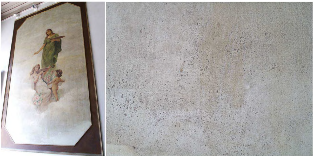
Figura 13 – (E) Plano geral da marouflage no hall da Biblioteca Pública Pelotense. (D) Detalhe no qual se observa a trama do tecido colado à parede. Fonte: Fotos do autor, 2015
