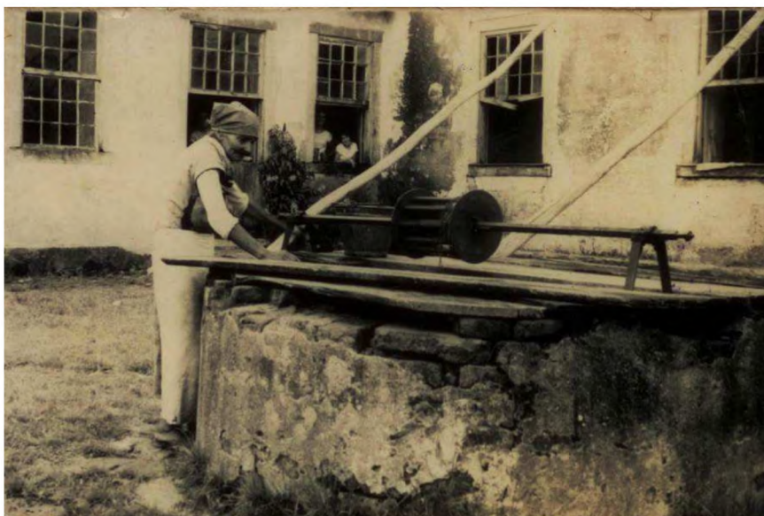
Figura 7: A índia Xandica retira água do poço. Ao fundo, a parede escorada com vigas de madeira (ca.1960). Foto: acervo de Maria Irtilia Vieira da Cunha.
