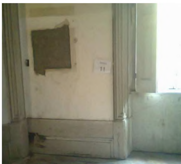
Figura 04 – Colocação de um ar-condicionado? Intervenção feita no casarão em uma das ocupações. Foto: Janaína Lamas Teixeira, 2011.
