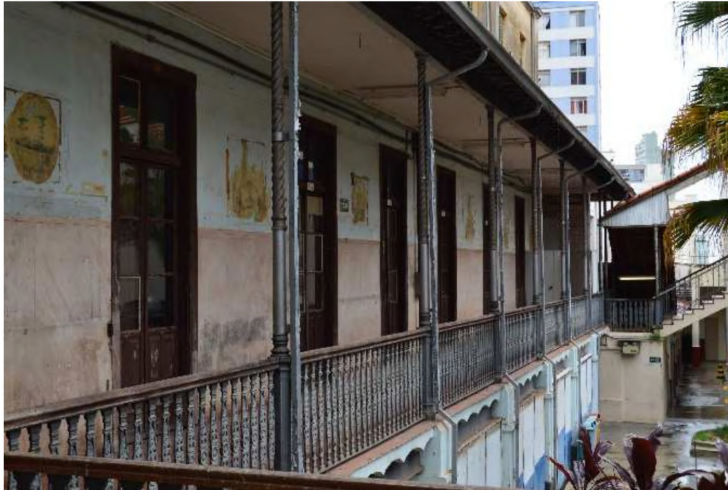
Figura 14: Residência do Barão de Itapura. Detalhe do alpendre junto ao jardim interno. Destaque para as abobadilhas de alvenaria de tijolos com vigas metálicas e para os elementos de ferro como gradis e colunelas. Fonte: Leonardo Rosa – PUC campinas.
