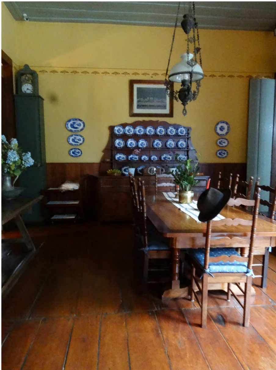
Figura 3: Sala da família ou sala varanda. Observa-se o assoalho em tábuas de peroba, revestimento de madeira nas paredes assim como discretas pinturas provavelmente em estêncil. O forro de madeira é em saia e camisa. FONTE: Acervo Prof. a Dr. a Rosana S. B. Parisi (2015).
