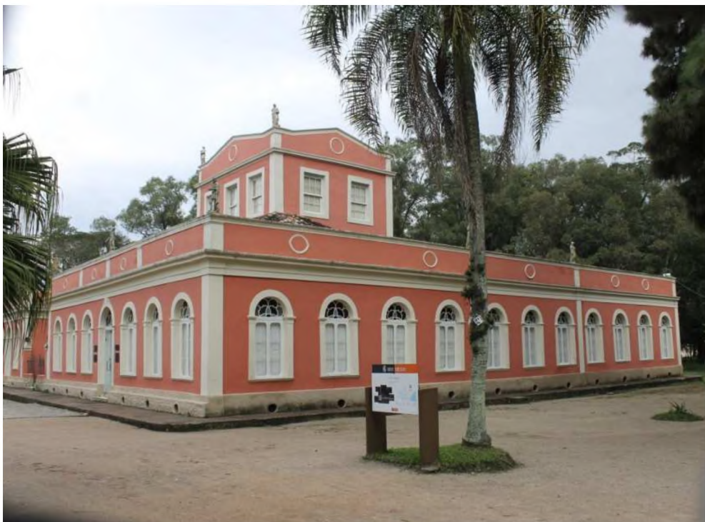
Figura 03: Fachada Museu Municipal Parque da Baronesa. Pelotas/RS. Fonte: Fotografia WMartins, 2014.
