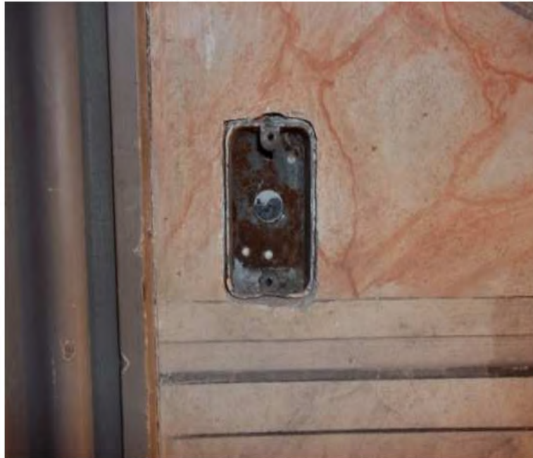
Figura 05 – Colocação de tomadas em uma das paredes com escariolas. Intervenção feita no casarão em uma das ocupações. Foto: Janaína Lamas Teixeira, 2011.
