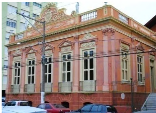
Figura 1 – Vista da fachada e entrada principal da casa número 8, praça Coronel Pedro Osório, Pelotas, RS, Brasil. Fotografia de Daniela B. da Fonseca, 2013.
