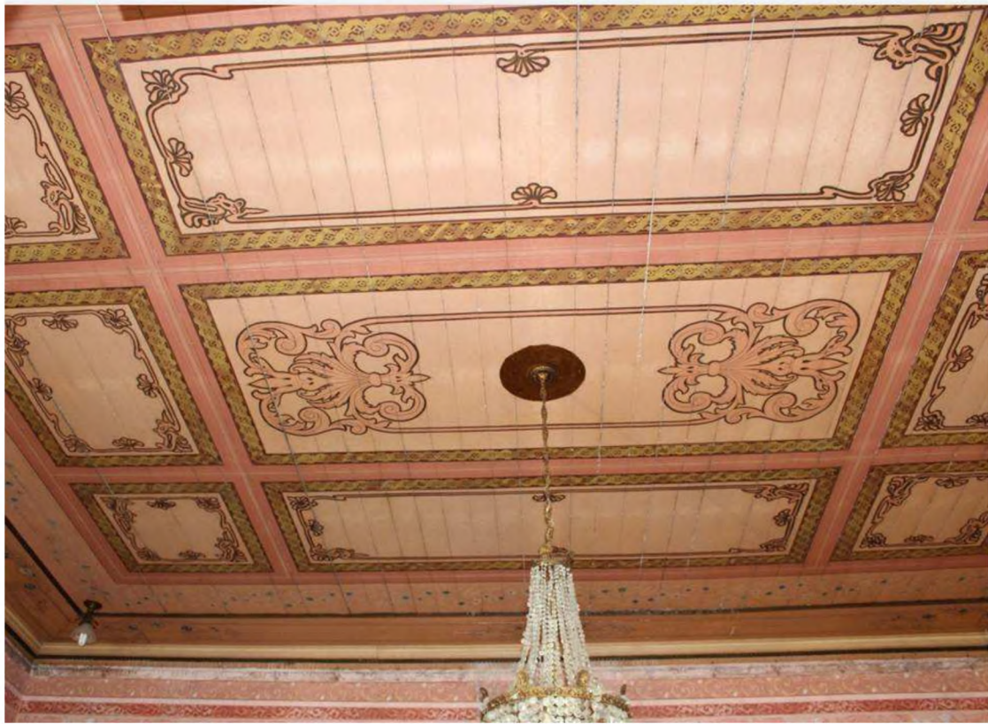
Figura 26: Forro do salão principal. Fonte Acervo da autora
