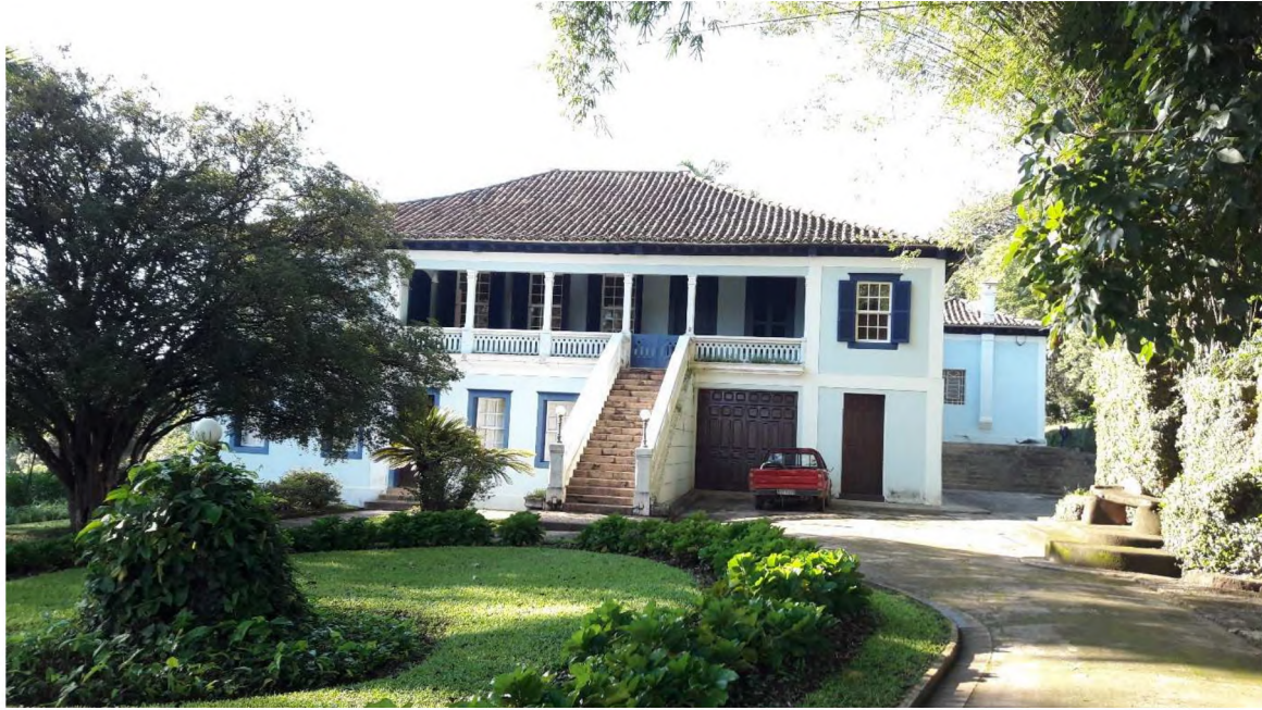
Figura 19: Fachada principal a partir do jardim frontal da casa. O programa residencial está disposto no piso superior, enquanto que o térreo era utilizado como depósito e alojamento para pequena escravatura, aquela relacionada com o trabalho diário dentro da casa senhorial. FONTE: Acervo dos autores (2016).
