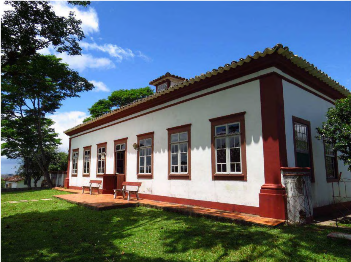
Figura 9: Aspecto da sede no dia do ato de tombamento estadual (2016). Foto: Mateus Rosada.
