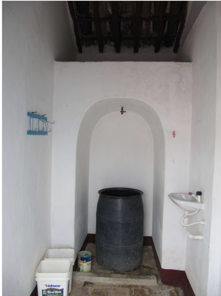
Figura 17: Banheiro da sede da Fazenda Morro Branco. Fotografia: Luiz Freire, 2017.
