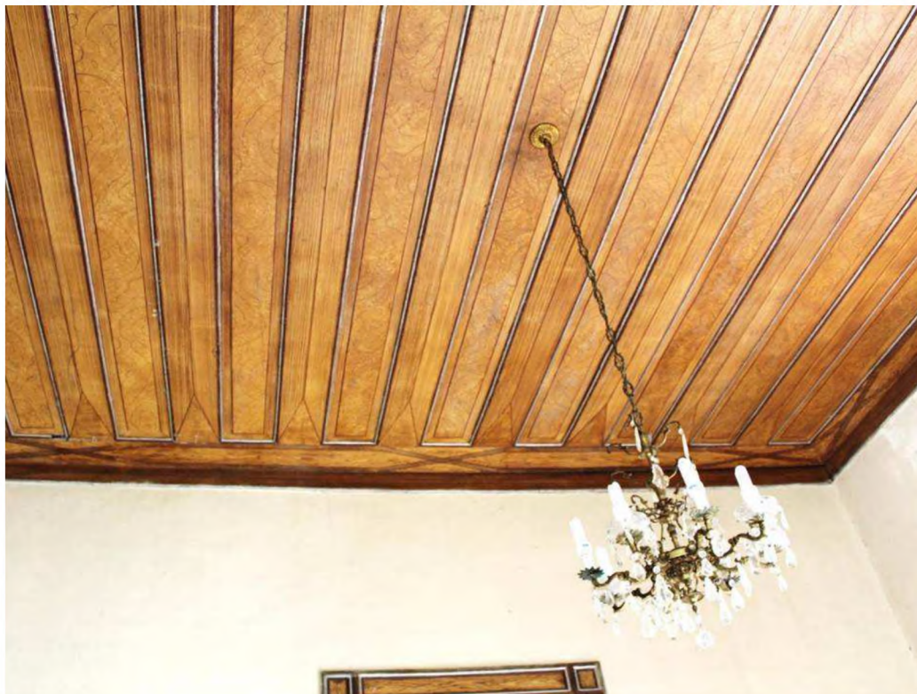
Figura 21: Forro da sala de recepção. Fonte: Acervo da autora
