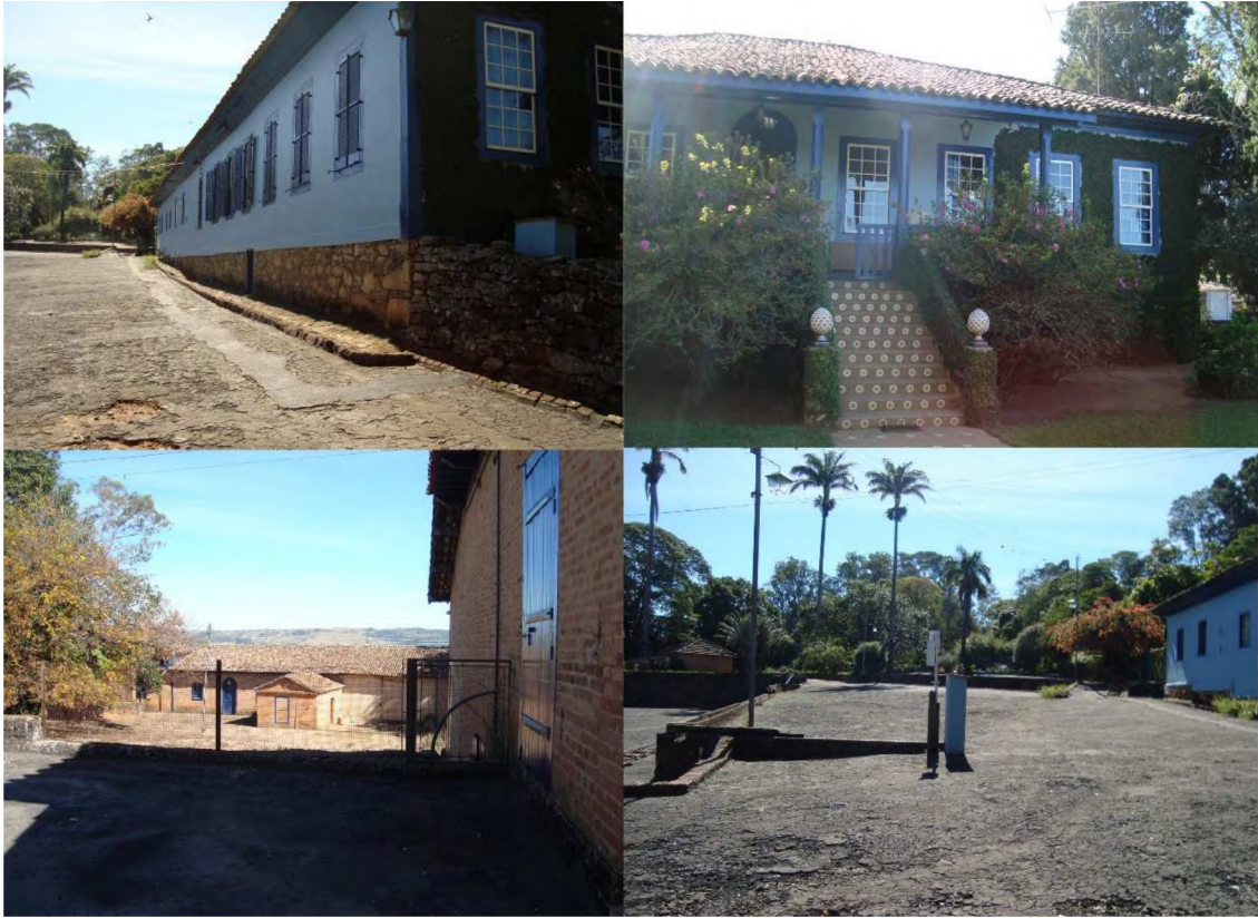
Figura 5: Imagem superior esquerda: porão elevado da casa sede, com embasamento em pedra canjicada. Imagem superior direita: fachada da casa sede, com o alpendre permitindo boa visibilidade e controle da insolação. Imagem inferior esquerda: vista a partir do terreiro de café para a tulha e engenho de serra, assentados na cota mais baixa. Imagem inferior direita, vista geral do terreiro de secagem, formado por patamares e por muros de arrimo em pedra. FONTE: Acervo dos autores (2016).
