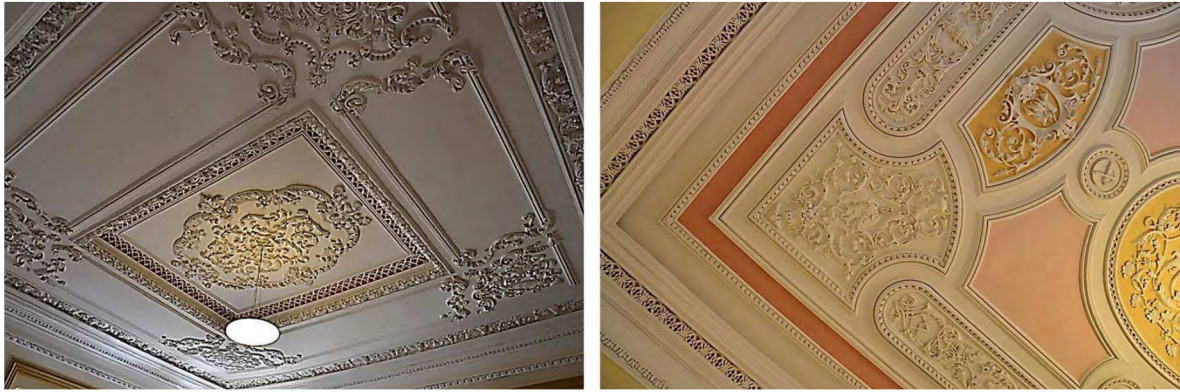
Figura 18 – Forros de estuque decorados em relevo. (E) Sala de festas. (D) Vista parcial sala de jantar. Antiga residência do Conselheiro Francisco Antunes Maciel. Arquitetura eclética. Pelotas, RS. Fonte: foto de Alexandre Mascarenhas, 2013.
