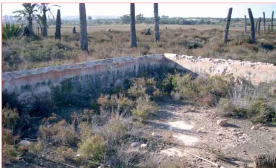
Balsa de riego en el Fondet de la Senieta
