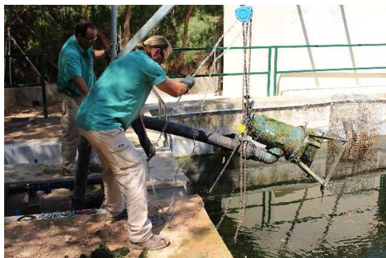
Limpieza bomba e instalación reja
