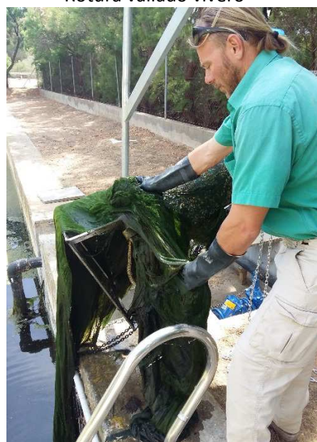
Limpieza bombas balsa regenerada
