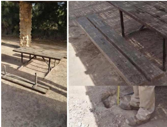
Reparación banco merendero
