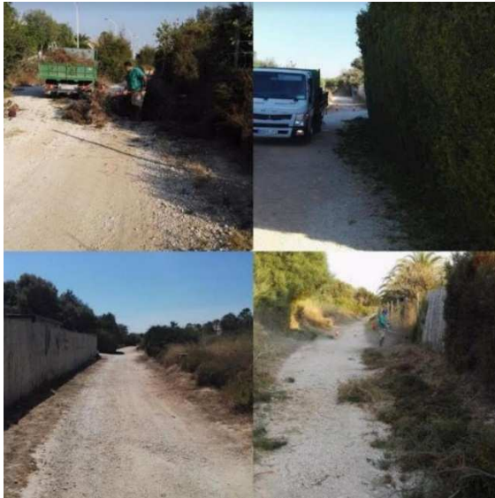
Desbroce y limpieza de caminos
