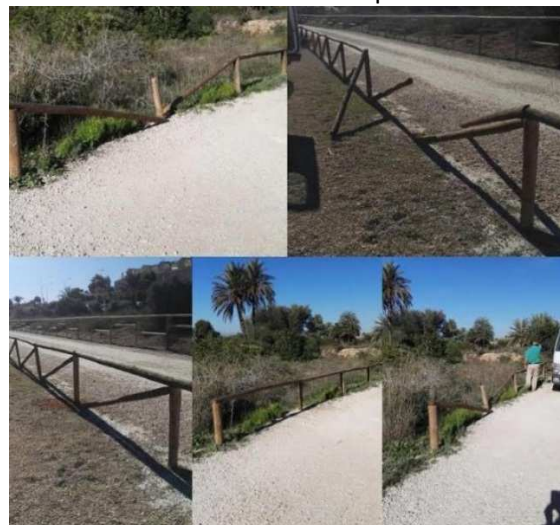
Reparación y refuerzo de talanqueras
