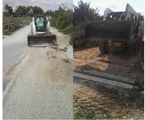
Reparación camino por escorrentía lluvia
