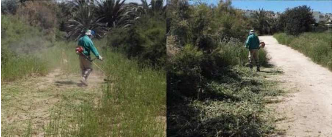
Limpieza y desbroce de caminos
