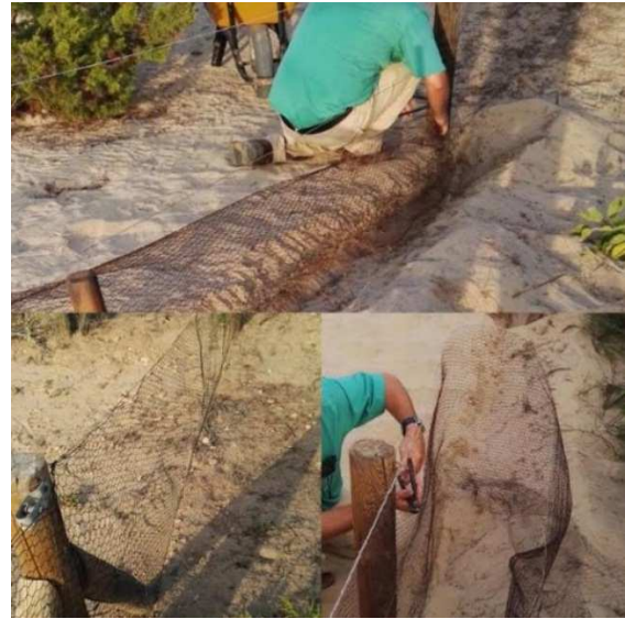
Reparación vallado tortuga mora
