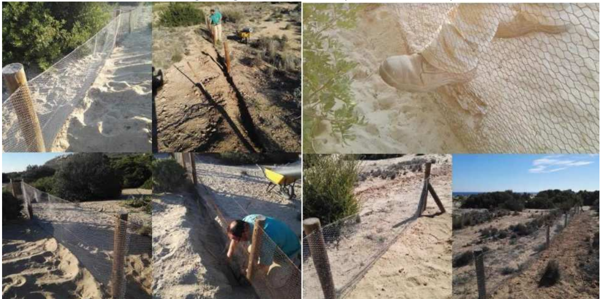
Reparación vallado recinto tortuga mora
