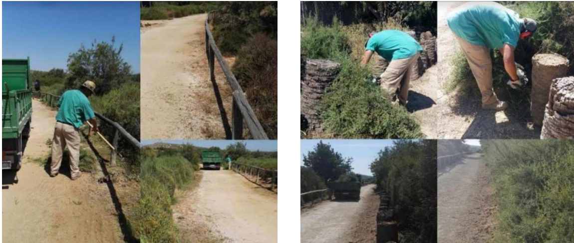
Desbroce y limpieza de caminos
