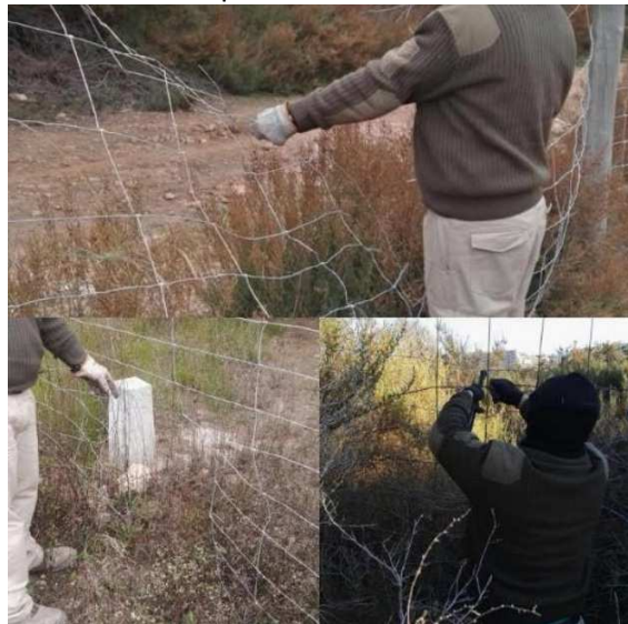
Reparación vallado cinegético
