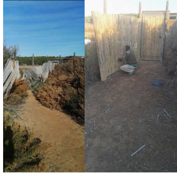
Reparación pasillo charca norte
