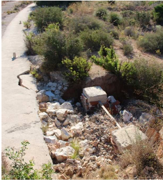
Reparación daños protección tubería, producido tras lluvias
