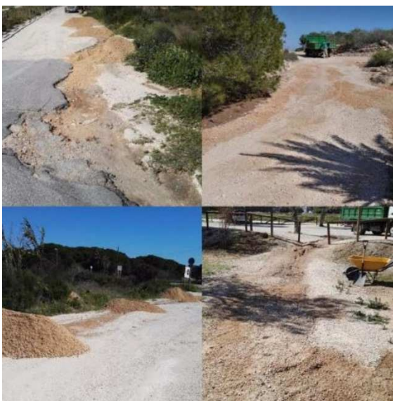
Reparación caminos por escorrentía
