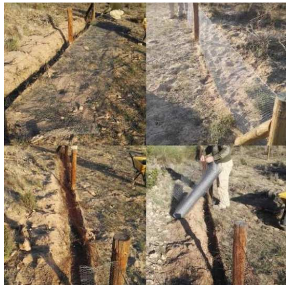
Reparación vallado recinto tortuga mora
