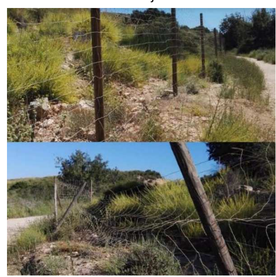
Reparación vallado cinegético
