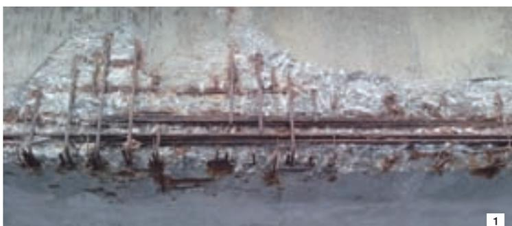
**Figura 1.** Ejemplo de elemento de hormigón armado degradado por la corrosión de las barras de la armadura.
