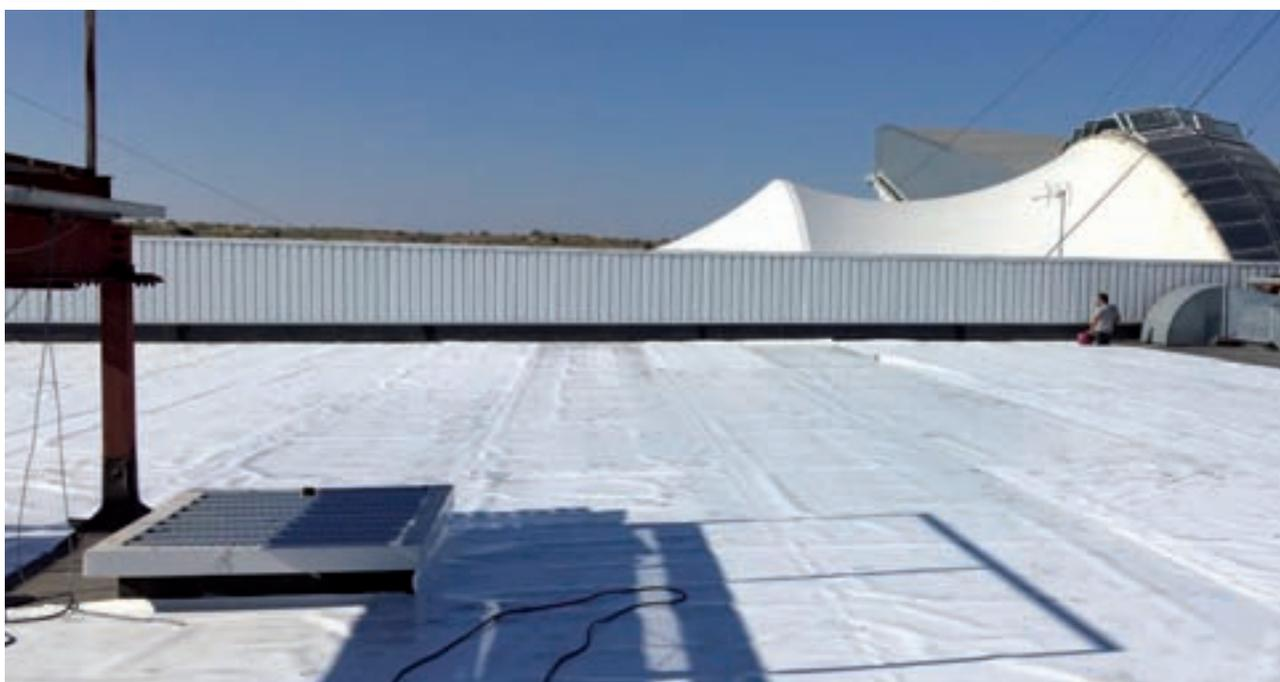
Los fallos en la impermeabilización originaron que además de las filtraciones se produjera absorción de agua en el aislamiento con la consiguiente pérdida de poder aislante y pérdida de estabilidad dimensional originando depresiones con formaciones de charcos, dificultando la rápida evacuación del agua hacia los sumideros.
