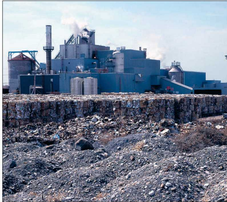
L'usine matanaise de Smurfit-Stone produit annuellement 150 000 tonnes métriques de carton. — PHOTOTHÈQUE LE SOLEIL
