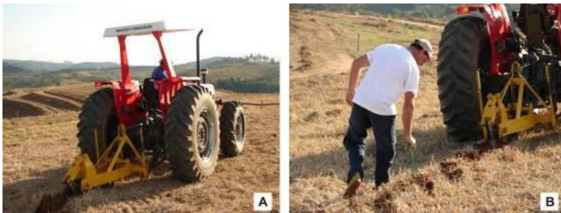
Figura 50 - Área com o mato já seco, após aplicação de herbicida, sendo preparada para o plantio com um subsolador florestal (A) e técnico medindo a profundidade de subsolagem com uma haste de ferro (B).
