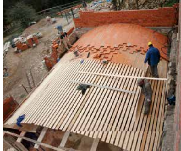
=peraris txecs aixecant una volta de 9 metres, sense formigó a Porqueres, Pla de l'Estany.
