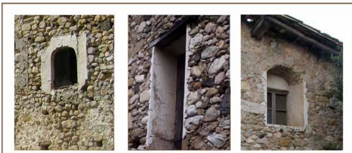
Obertures de lliscat de guix i tancament per l'interior a Besalú, Sant Ferriol i Dosquers (d'esquerra a dreta)
