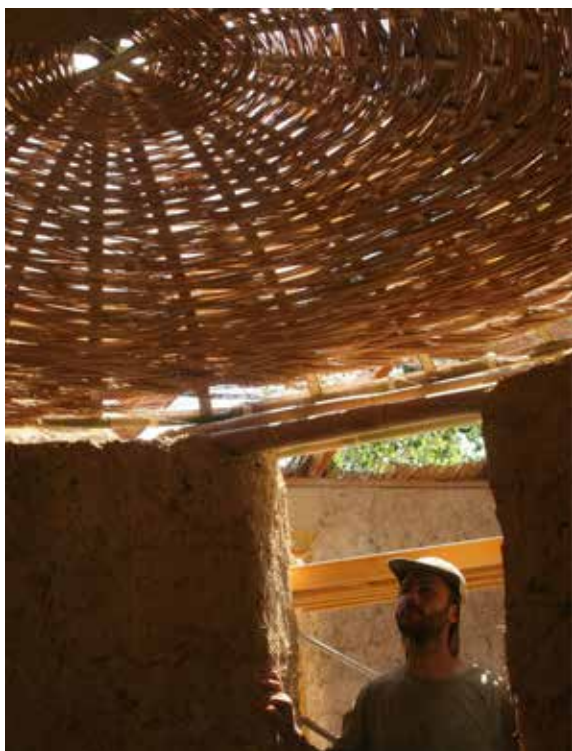
Entramat de canya per conformar una falsa cúpula a La Pera, Baix Empordà
