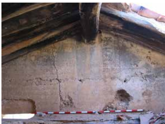
Imatge per la documentació gràfica del revestiment de l'aparell constructiu d'una estructura murària. Mas Vidal, Les Pobles, Aiguamúrcia (Alt Camp)
