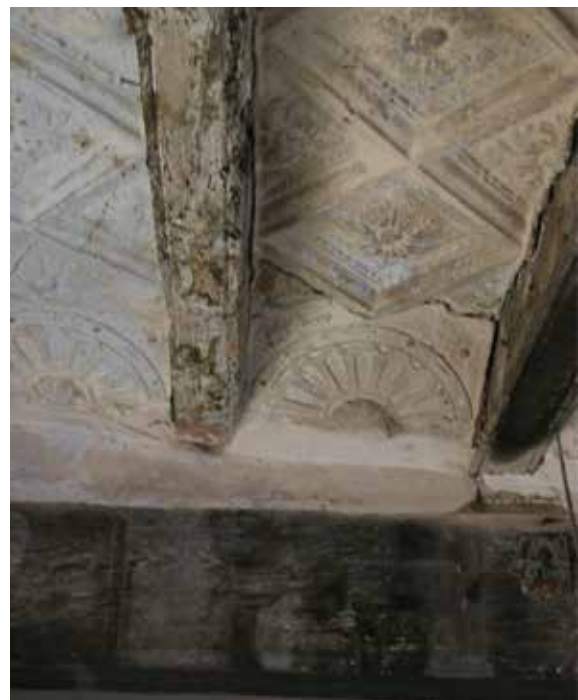
Detall d'entrebogat de guix tradicional al veïnat de Dosquers, Alt Empordà.
