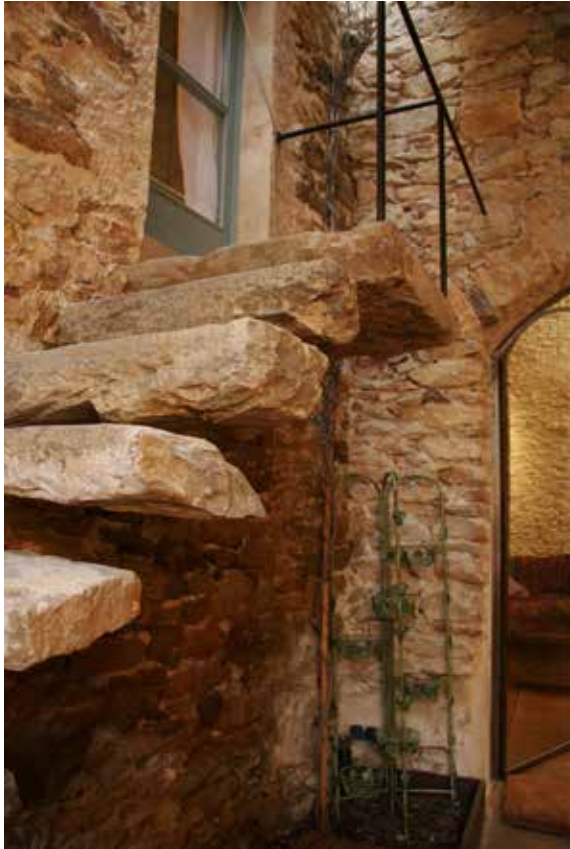
Escala en voladís a base de lloses en una casa entre mitgeres a Fonteta, Baix Empordà
