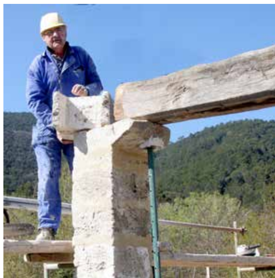
Carreus de pedra travertí, al Mas Congost de Porqueres, Pla de l'Estany
