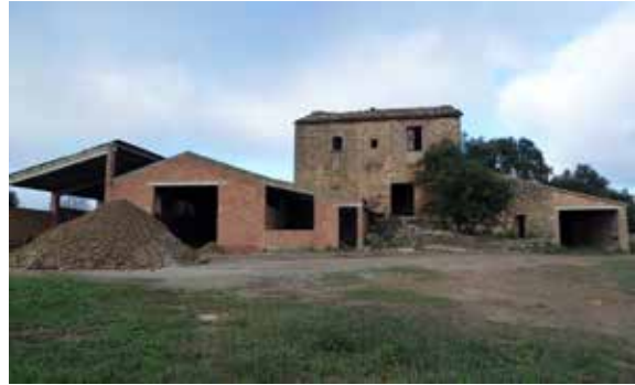
Foto núm. 4. Estat inicial abans d'inici d'obres
