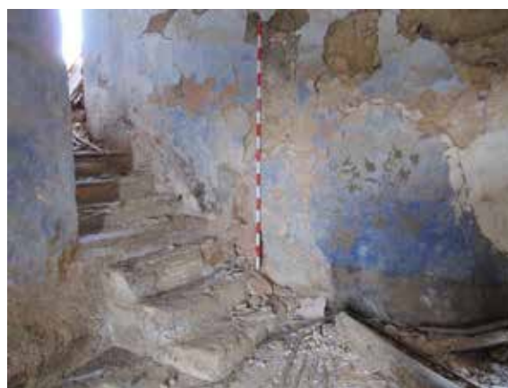
Imatge del procés de documentació gràfica de l'estat actual que presenten les parts i els elements constructius d'una masia, abans de procedir a les actuacions de registre i documentació arquitectònica. Mas Serrà, Vila-rodona (Alt Camp)
