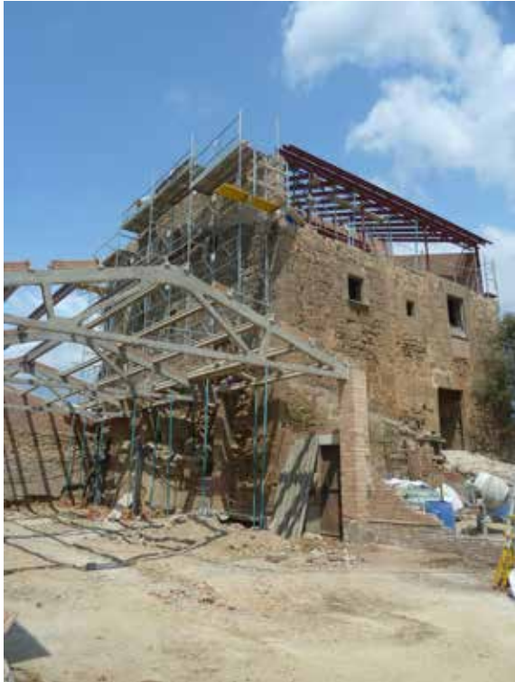
Foto núm.3: Procés d'obra. El tractament i la recuperació dels elements constructius d'època recent també han format part de la proposta d'intervenció en el conjunt edificat de la Masia de Cal Puig.
