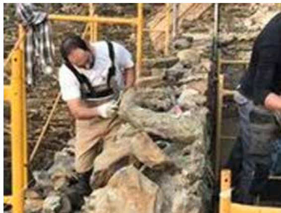
Execució d'un mur de pedra calcària, al Mas Can Roquer de Rabós de l'Empordà, Alt Empordà, a base d'emparedat tradicional agafat amb morter de fang i calç
