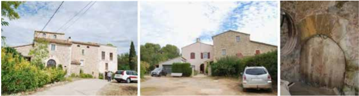
La Masseria: masoveria i casa nova, casa vella i portal d'accés al molí.
