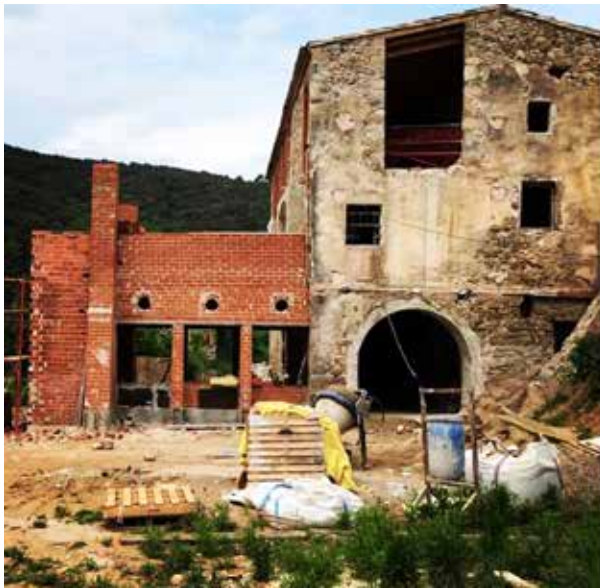
2. Formació de grans obertures mitjançant arcs, per dotar la planta baixa d'un espai diàfan amb generosa ventilació ponent – llevant
