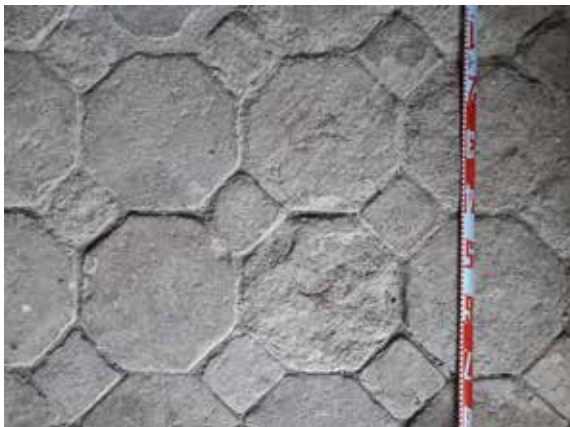
Detall fotogràfic de les rajoles d'un paviment com a referència d'un element singular del programa constructiu d'un conjunt arquitectònic. Mas de Tell, El Milà (Alt Camp)
