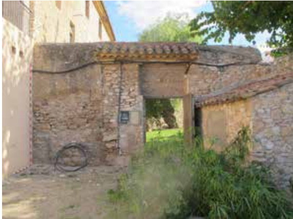
Procés de documentació de les parts i elements de les construccions auxiliars de l'edifici principal com integrants del conjunt arquitectònic de la masia Mas de l'Abeurador, La Canonja (Tarragonès)
