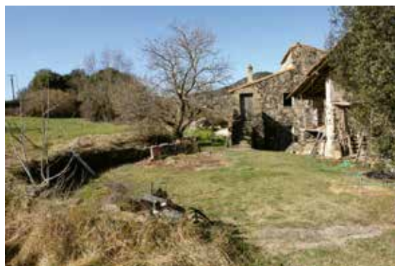
Estat inicial de la masia de Santa Pau (la Garrotxa). Foto: Bosch - Capdeferro Arquitectes.
