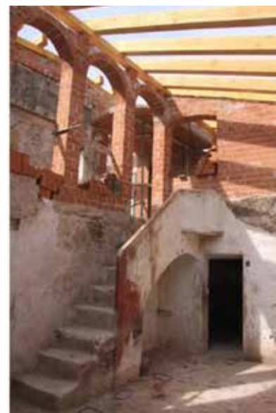
4. Canvi de coberta a base d'estructura de fusta massissa composta per embigat, cèrcol, entrebigat, 20 cm de suro, cambra ventilada a base de doble rastrellat i teula ceràmica tradicional
