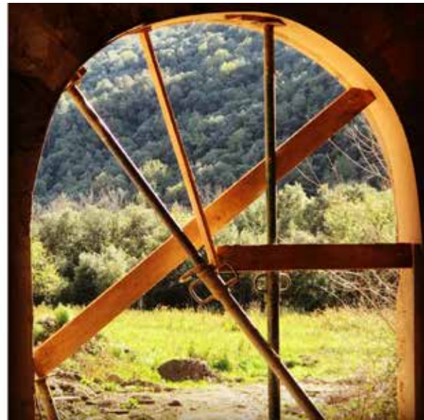
2. Formació de grans obertures mitjançant arcs, per dotar la planta baixa d'un espai diàfan amb generosa ventilació ponent – llevant
