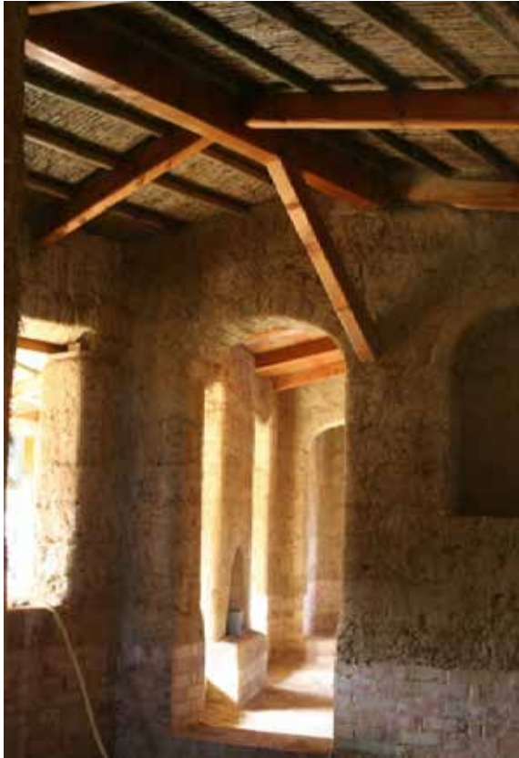
Imatge d'una casa feta amb terra comprimida, combinant tècnica de cob i d'adob a La Pera, baix Empordà
