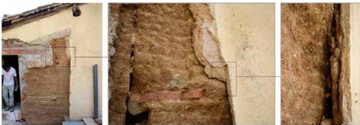
Diverses pells aplicades al mur original de tapial de la Masia Cal Doctor d'Alella (Cristina Thió, 2018).
