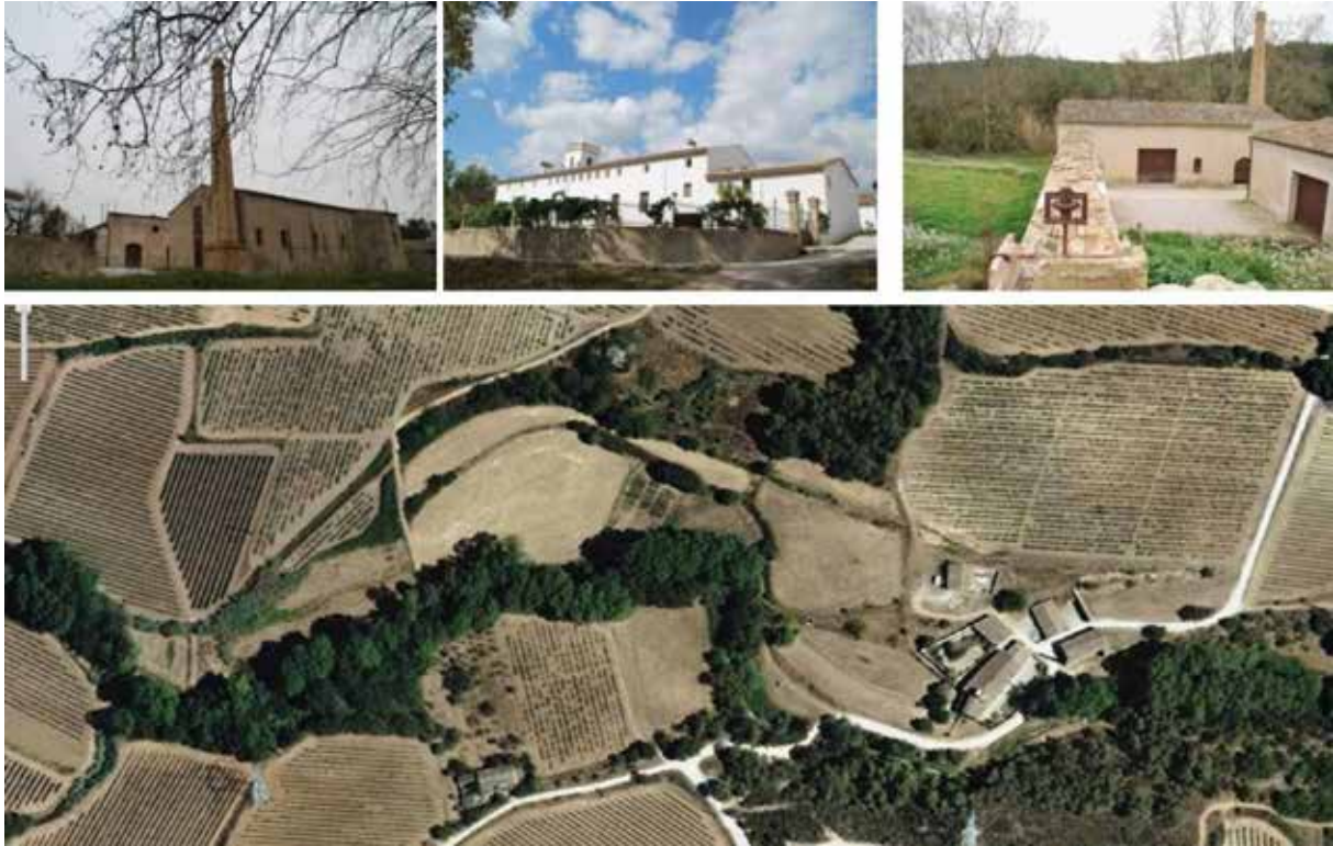
Can Vallès de la Riera: edifici residencial, construccions del segon molí i part del rec amb la comporta. Ortofoto (ICGC). Context de Can Vallès de la Riera, on es reconeixen les traces del rec.
