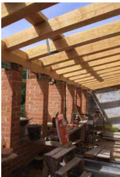
4. Canvi de coberta a base d'estructura de fusta massissa composta per embigat, cèrcol, entrebigat, 20 cm de suro, cambra ventilada a base de doble rastrellat i teula ceràmica tradicional
