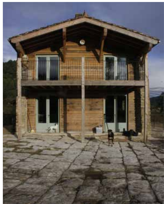
Imatge de la façana migdia
