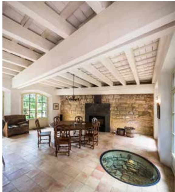
Visió d'un sostre de fusta massissa, dimensionat segons els requeriments normatius actuals a Peratallada, Baix Empordà
