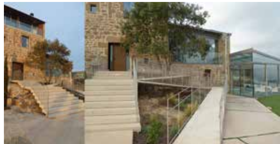
Foto núm.6: Facilitar i resoldre l'accessibilitat a la masia. De manera directament juxtaposada i per contrast, es resol la nova accessibilitat d'escales i rampa en convivència amb i sobre les restes del pujador de llambordes originals texturades i erosionades de la primitiva rampa d'accés per animals i persones.
