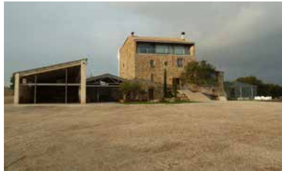
Foto núm. 5. Estat final després de la intervenció
