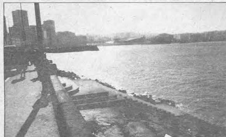
Obras de defensa da costa (Orzán)
