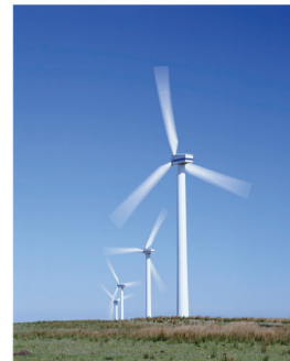
Un parque eólico que convierte la energía cinética del aire en energía eléctrica. (Image Slate.)
