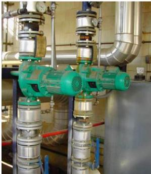
**todas las pérdidas de carga** del circuito, o sea debe seleccionarse para que trabaje en el denominado punto de trabajo de la instalación. Más adelante, en el cálculo y diseño del circuito hidráulico verás cómo se realiza esta selección.
