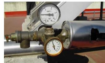
**El RITE establece la obligación de instalar una válvula de seguridad o alivio en cada circuito, aparte de las válvulas de seguridad en otros equipos como acumuladores, captadores y calderas.**
