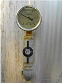
□ En circuito cerrado (el primario y el secundario de inercia), se asegura una presión relativa de 1 bar en la parte superior del circuito (generalmente los captadores del primario), para evitar la entrada o succión de aire al circuito.
