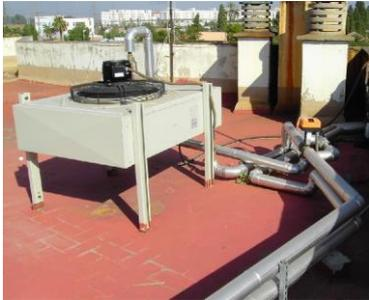
a) Dotar a la instalación de la posibilidad de **disipar dichos excedentes** (a través de equipos específicos o mediante la circulación nocturna del circuito primario);
