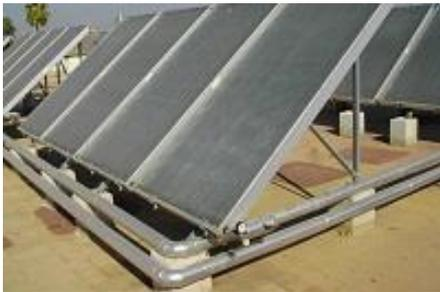
En primer lugar, resaltar que las tuberías del primario, indicado por el CTE, podrán usarse el cobre y el acero inoxidable, aunque es común el uso de acero negro siempre y cuando no transporte agua para consumo humano. Si son de cobre conviene que sean con soldadura fuerte, para soportar las altas temperaturas. Si son de acero inoxidable, su principal inconveniente es el precio.
