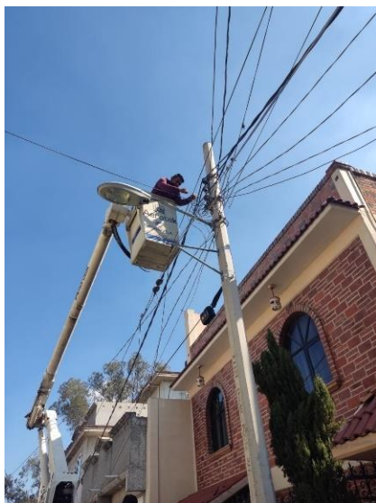
Imagen 41 Mantenimiento de Alumbrado. Fuente: Comunicación Social de Tonanitla, 2022.
