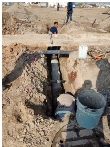
Imagen 56 Introducción de drenaje. Fuente: Comunicación Social de Tonanitla, 2022.
