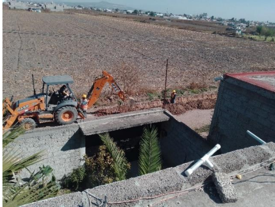
Imagen 55 Trabajos de introducción de drenaje. Fuente: Comunicación Social de Tonanitla, 2022.
