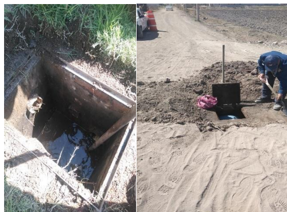
Imagen 54 Mantenimiento de registros de drenaje. Fuente: Comunicación Social de Tonanitla, 2022.
