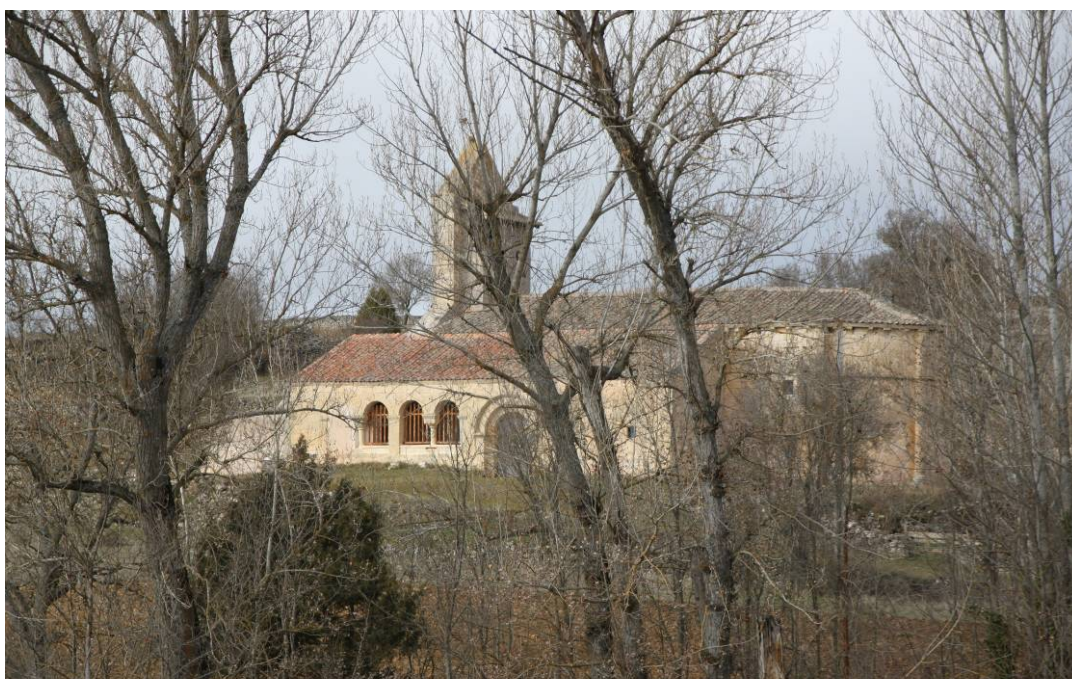
69. Aldehuelas de Sepúlveda. Exterior
