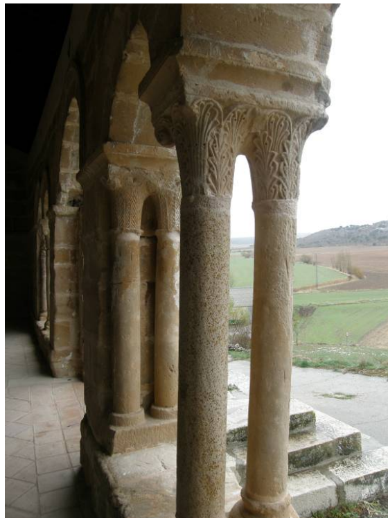
44. Jodra del Pinar. Detalle de la arquería
