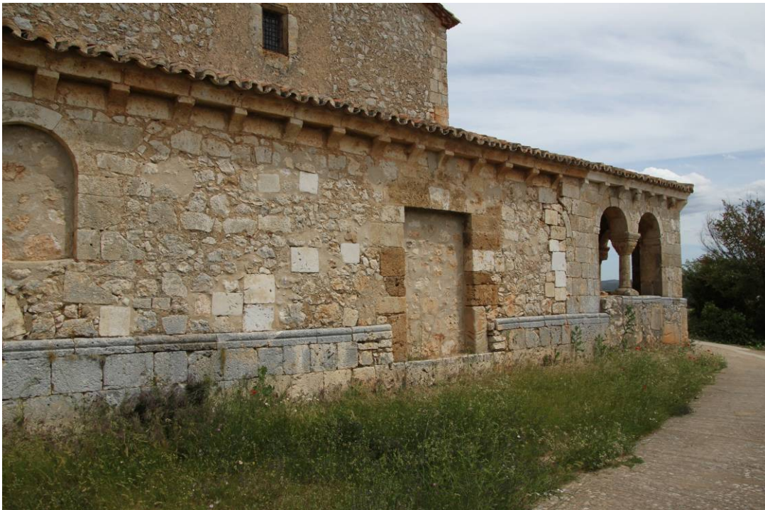
169. Andaluz. Panda oeste
