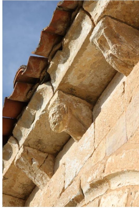
107. Requijada. Detalle de la cornisa
