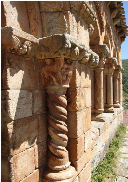
67. Canales de la Sierra. Detalle de la arquería
