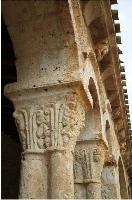
176. Barca. Detalle de la arquería
