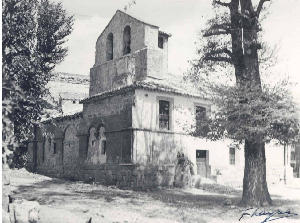
62. Yela. Exterior, 1933, foto F. Layna
