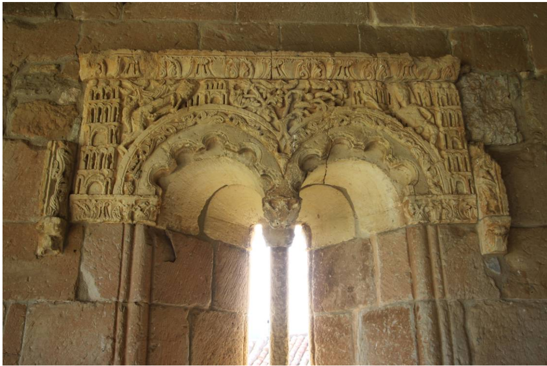
14. Rebolledo de la Torre. Vano del cierre oeste desde el interior
