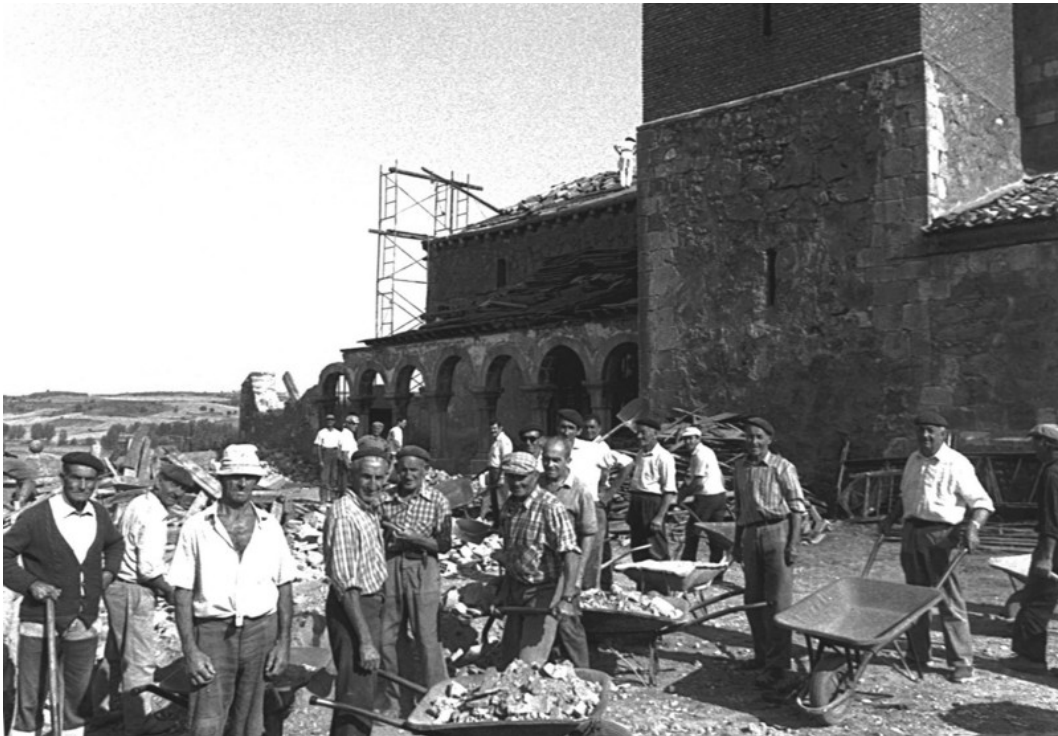
178. Berzosa. Iglesia en obras, c. 1990, autor desconocido
