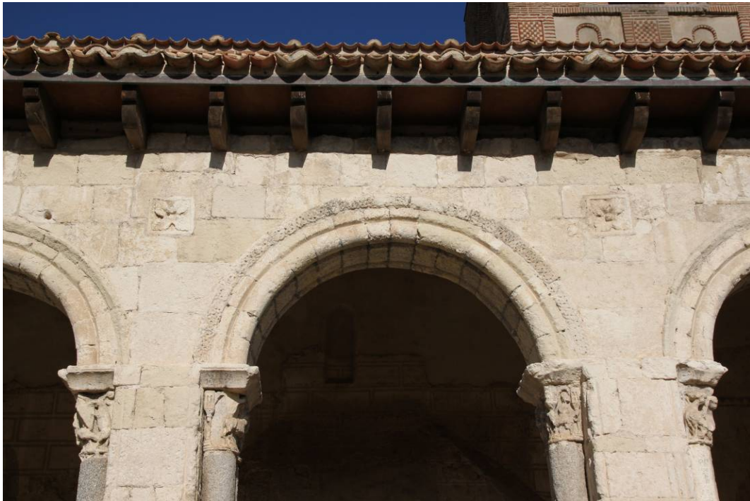
3. Arévalo. Detalle del acceso meridional
