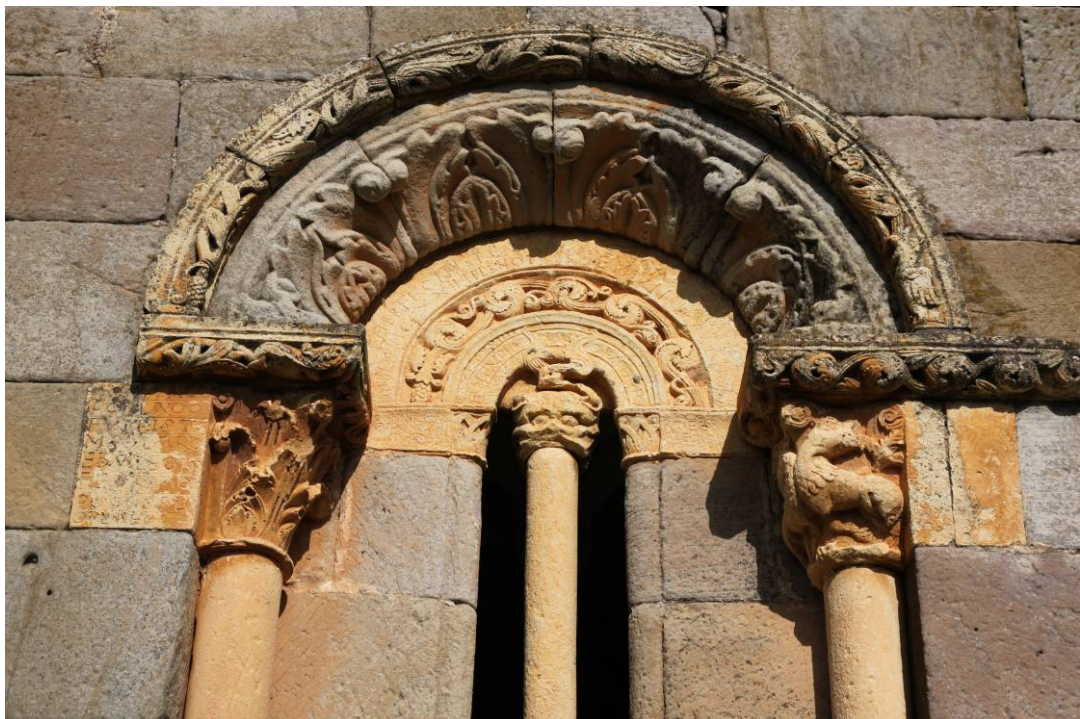
15. Rebolledo de la Torre. Vano del cierre oeste desde el exterior
