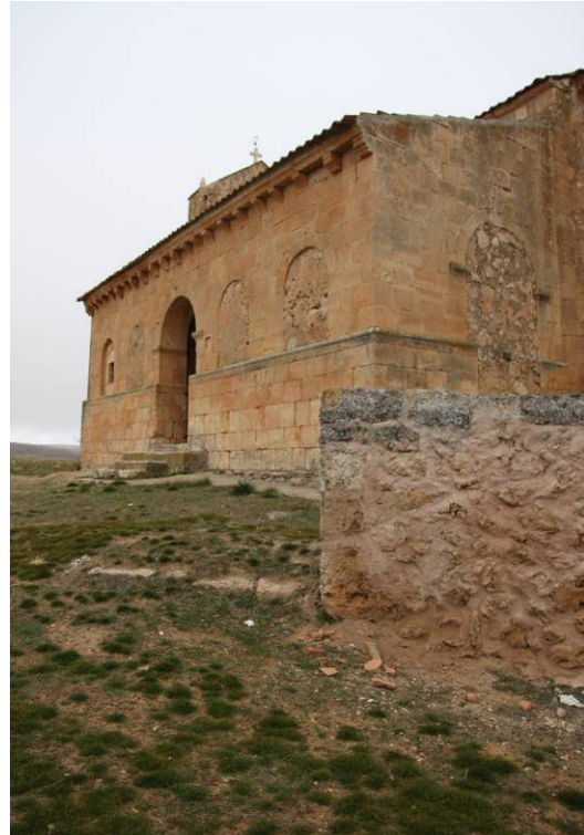
158. Valdevarnés. Exterior desde el sureste
