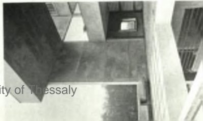
Abb. 114. LE CORBUSIER - MAUR DE MONZIE in GARCHES bei Paris, 1927-28 Krenn, das Haus wurde von der Bauwelt nicht ohne Grund als „Kleinwerk“ bezeichnet. Die Konstruktion des Gebäudes ist ein Beispiel für die „Kleinwerk“-Kategorie. Das Konzept der „Kleinwerk“-Kategorie ist ein Beispiel für die „Kleinwerk“-Kategorie. Das Konzept der „Kleinwerk“-Kategorie ist ein Beispiel für die „Kleinwerk“-Kategorie.
