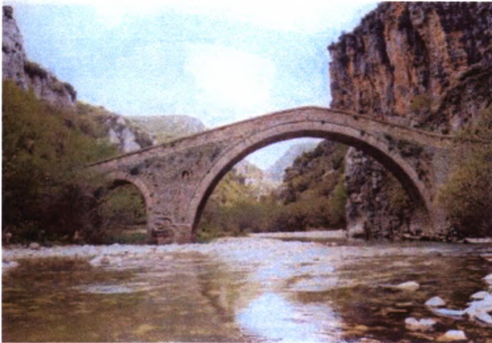
Εικόνα.5.2: Γέφυρα Μίσιου, Ζαγόρι
