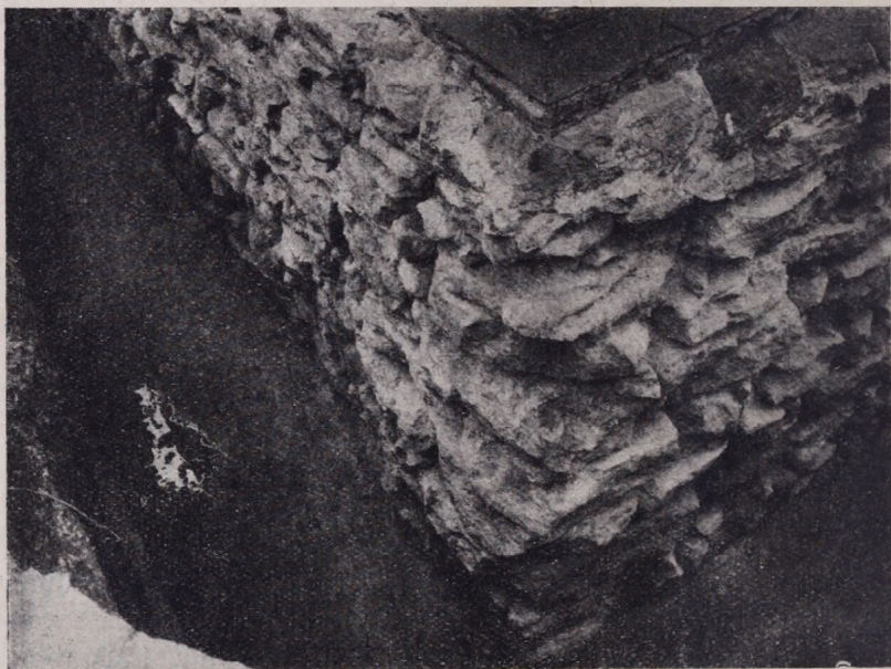
4. ábra. A pécsi székesegyház északnyugati tornyának alapzata. Grundmauer des nordwestlichen Turmes des Domes in Pécs.
