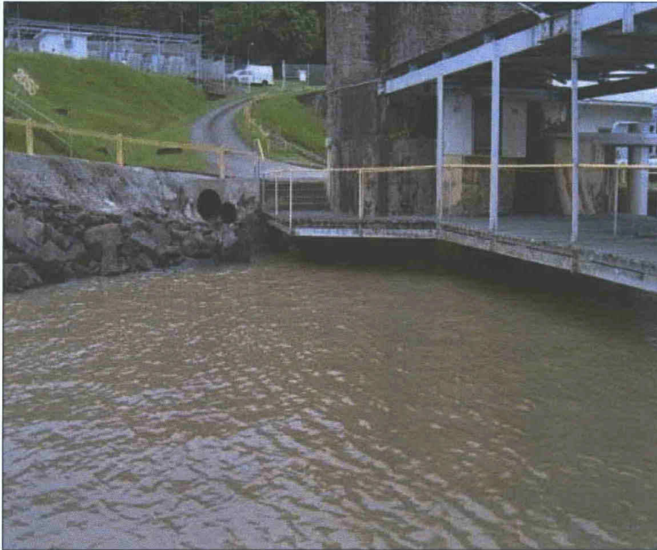
Figura 23. Toma de agua de Paraíso (PRAW).
