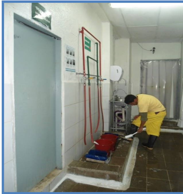
Figura N° 10: Aduanas sanitarias y entrada a áreas de proceso.
