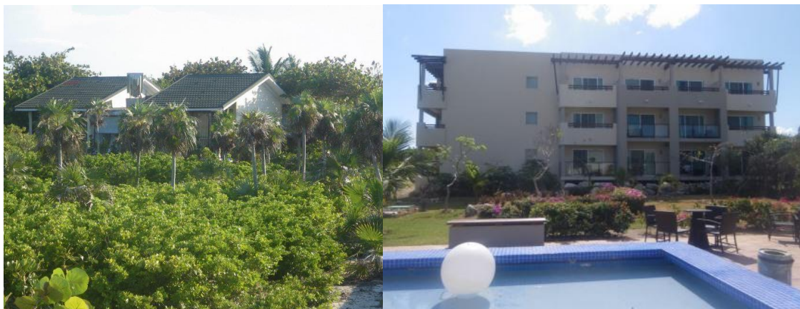
Figura 76. Dos de las villas hoteleras con distinta valoración (Hotel Sol a la izquierda con valoración Buena, Hotel Eurostars a la derecha con valoración Baja).
