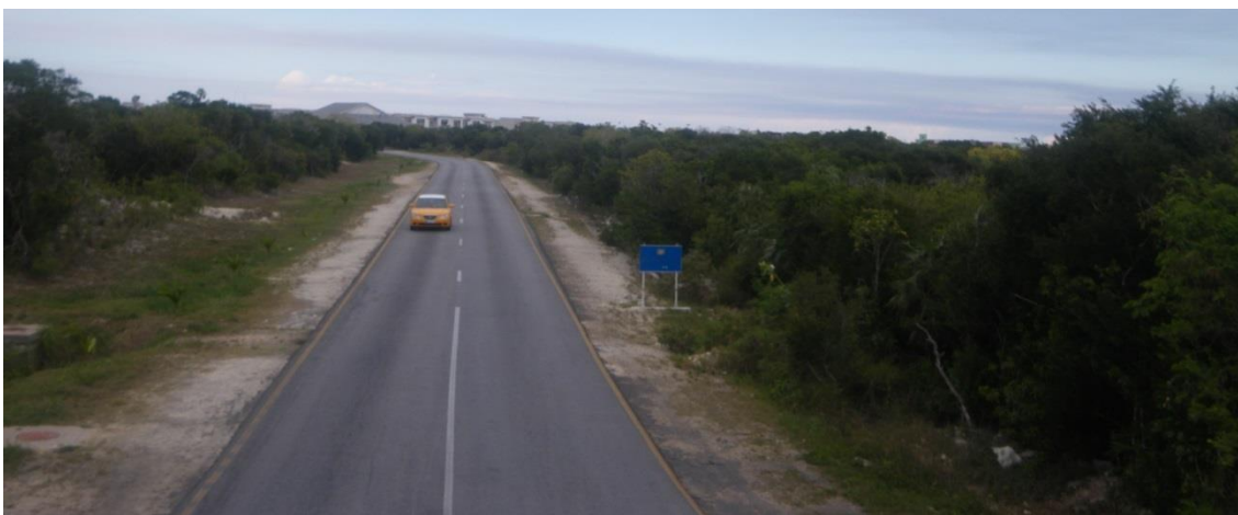
Fotografía 29. La construcción de viales según la normativa de la Isla de Cuba ha propiciado que en algunos casos los desmontes laterales sean excesivos (Fotografía: M. Burgui).
