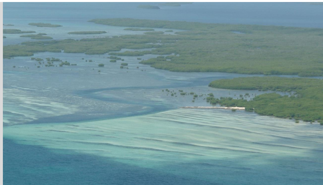
Fotografía 16. Vista aérea parcial de la unidad 32 al sureste del cayo. En primer plano se observa el final del pedraplén y el arrastre de arenas que las corrientes llevan hacia esta zona. Entre los manglares, lagunas de acumulación diferencial (Fotografía: GEOCUBA).
