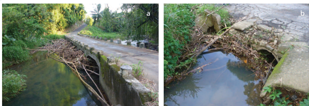
Exemples d'ouvrages fortement comblés en amont par des embâcles. (a) et (b) Ouvrages colmatés sur des rivières martiniquaises.
