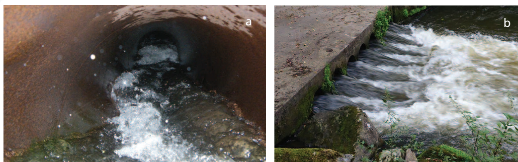
Exemples de fortes vitesses au niveau de passages busés. (a) Buse sur la rivière Saint-Étienne (Réunion), (b) Gué sur la Maronne.
