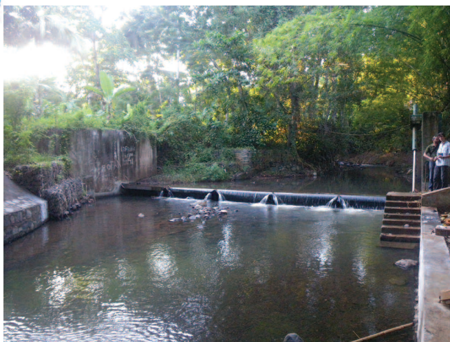
Exemple d'un seuil constitué d'organes mobiles.
