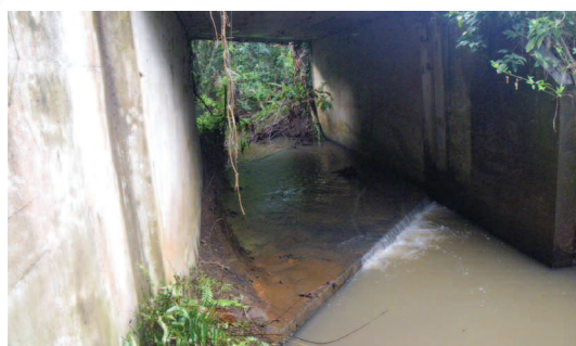
Exemple de faibles tirants d'eau au niveau d'un radier sous un pont routier. Passage Beija (Mayotte).
