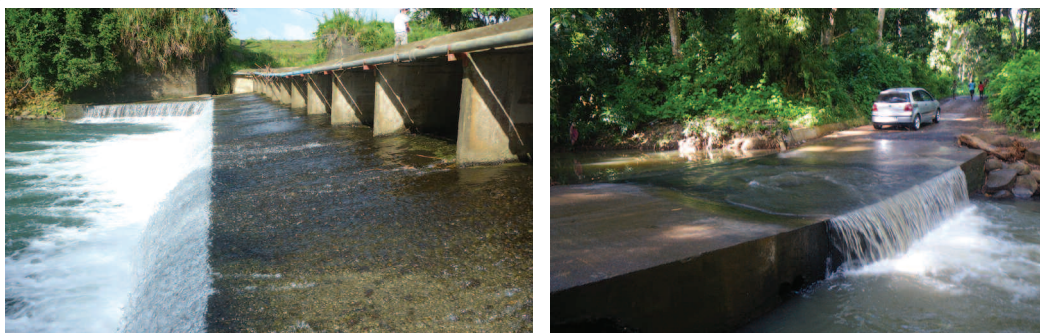
Écoulement sur un parement incliné présentant une chute aval. (a) Grande Rivière à Goyaves (Guadeloupe), (b) Passage à gué de Moala sur l'Ourovéni (Mayotte).
