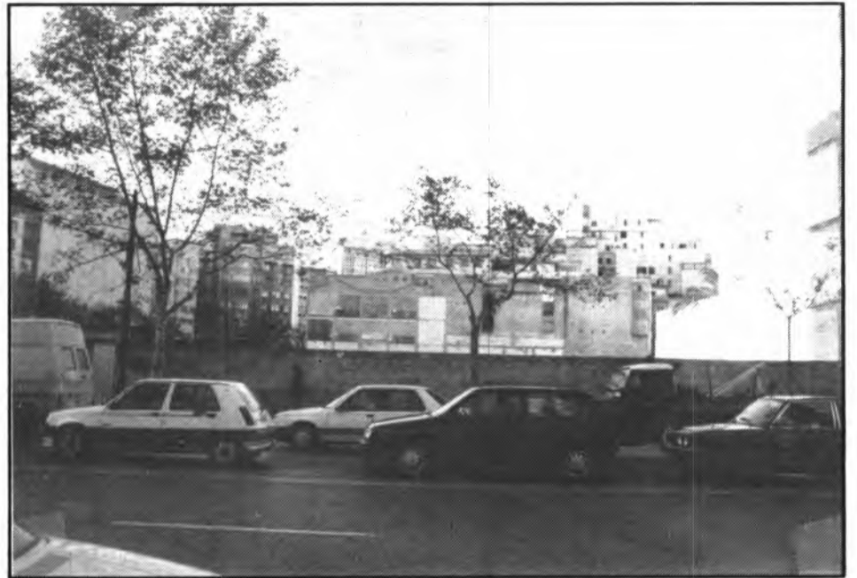
Les obres d'enderroc per a construir El Corte Inglés estan pràcticament acabades.
