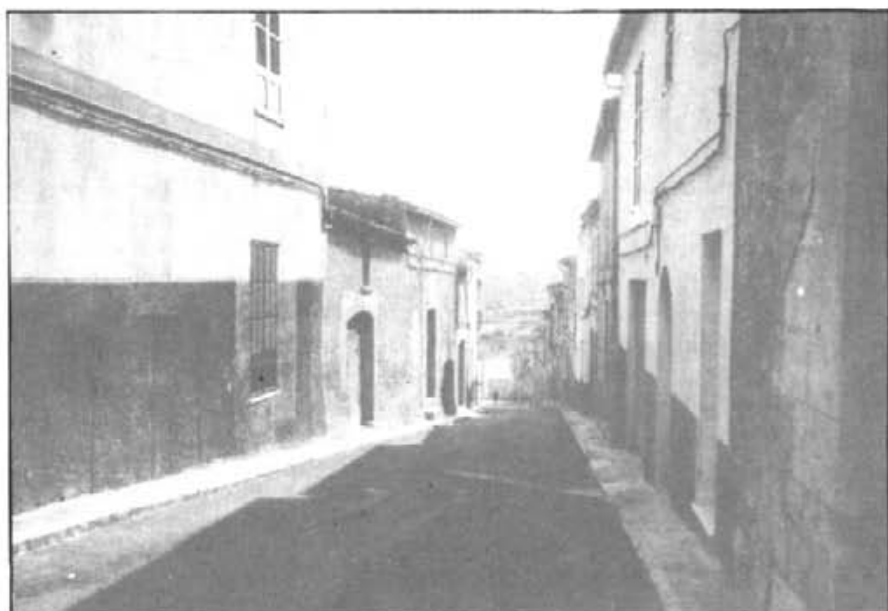
El carrer de Ses Tres Creus va des de la mateixa plaça de Ses Tres Creus fins al carrer de Santa Catalina Tomàs. Era un dels que formaven el límit de l'antiga població reial de Montuïri
