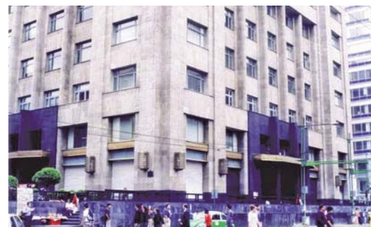
Fig. 15. Edificio que presenta el fenómeno de emersión, al estar cimentado sobre pilotes de punta.
