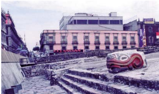
Fig. 13. Ruinas de una antigua pirámide azteca afectada por asientos diferenciales. Al fondo se aprecia un edificio colonial afectado también por asientos diferenciales (grietas en la fachada).
