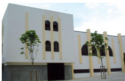
Figura 4- Instalações da Canto Firme
