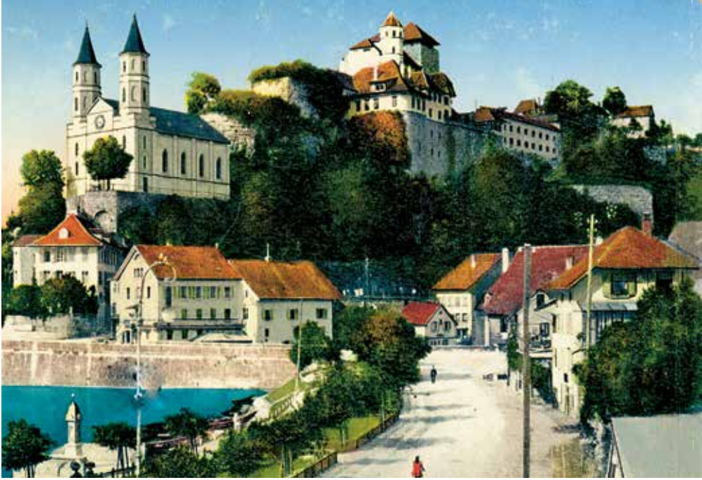
Abb. 5: Einzug der Moderne: Die Panorama-Ansichtskarte zeigt die 1912 eröffnete Betonbrücke im Kontrast zur altertümlich wirkenden Festung. Der Zöglingstrakt am rechten Bildrand befindet sich noch im Zustand vor der Aufstockung von 1917. (PKH)
