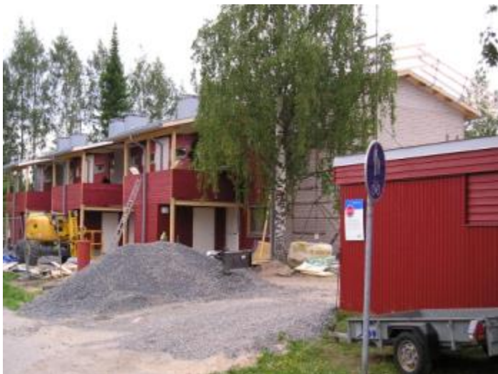
Kuva 18. Harjakatto jatkuu parvekkeiden yli ja räystäät ovat n. 50cm pitkät
