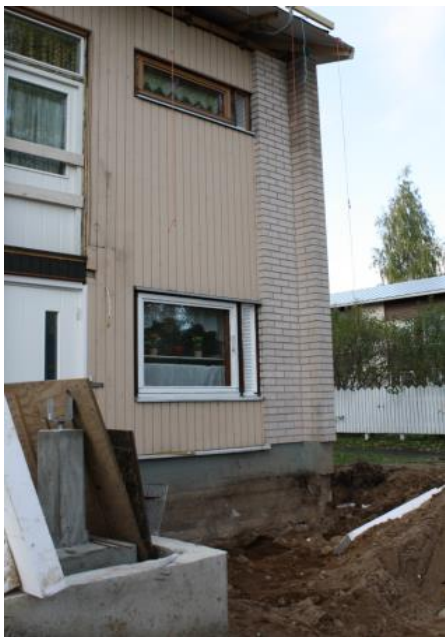
Kuva 32. Maaperänäyte valesokkelin alatasolta otettiin B-talosta. Näytteenotto kuoppa näkyy kuvassa ikkunan alapuolella.
