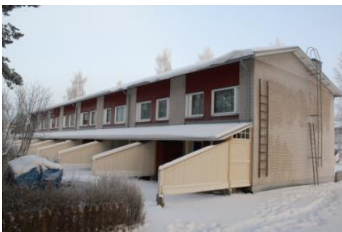
Kuva 20. Takapihoille rakennettiin katettu terassi.
