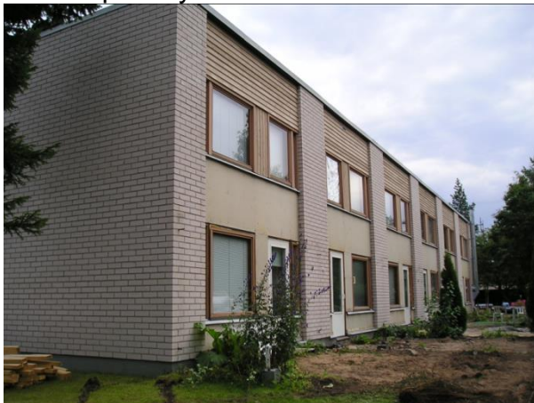
Kuva 17. Takapihoilla on lähes joka asunnossa ollut kukkapenkki kiinni sokkelirakenteessa.
