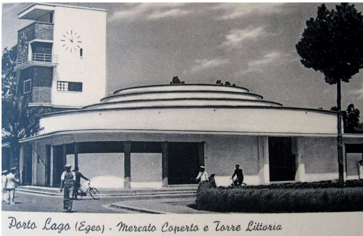
Edifici razionalisti a Portolago 205
