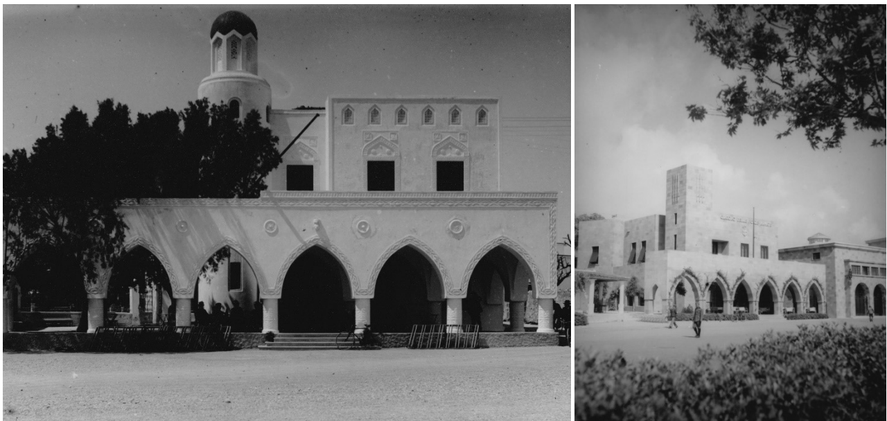
Rodi: il circolo delle Forze Armate prima e dopo le demolizioni
