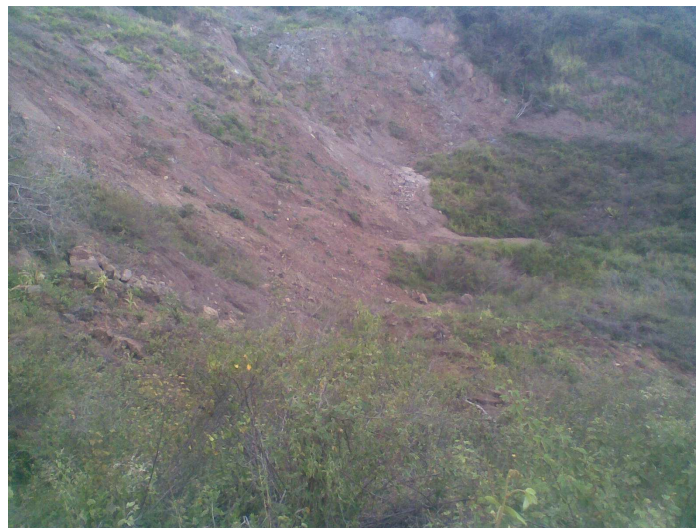
Foto 19 Deslizamiento predio GB vereda Méjico
