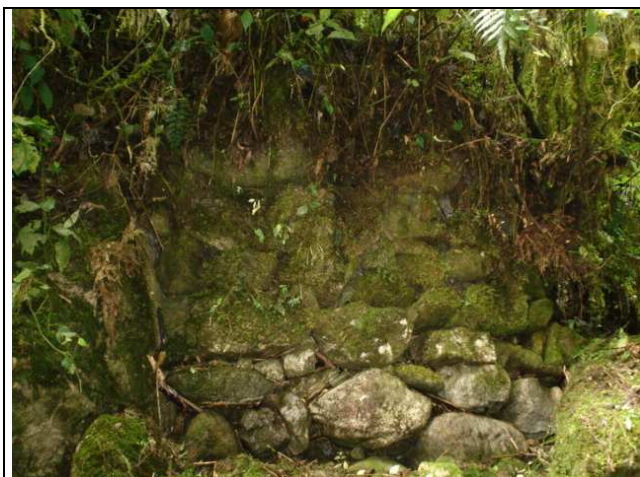
Muro de contención construido por los españoles para labores de minería en Sisavita
