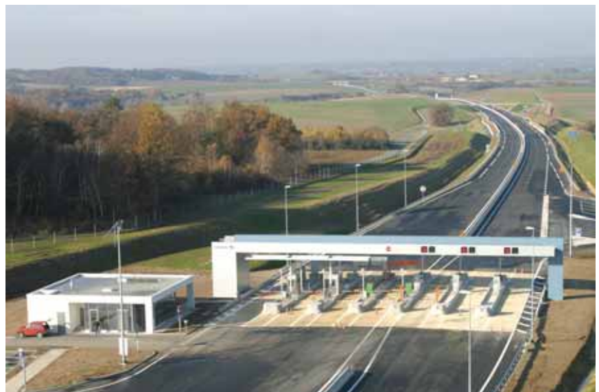
New Saint Christophe sur le Nais toll station on the A28
