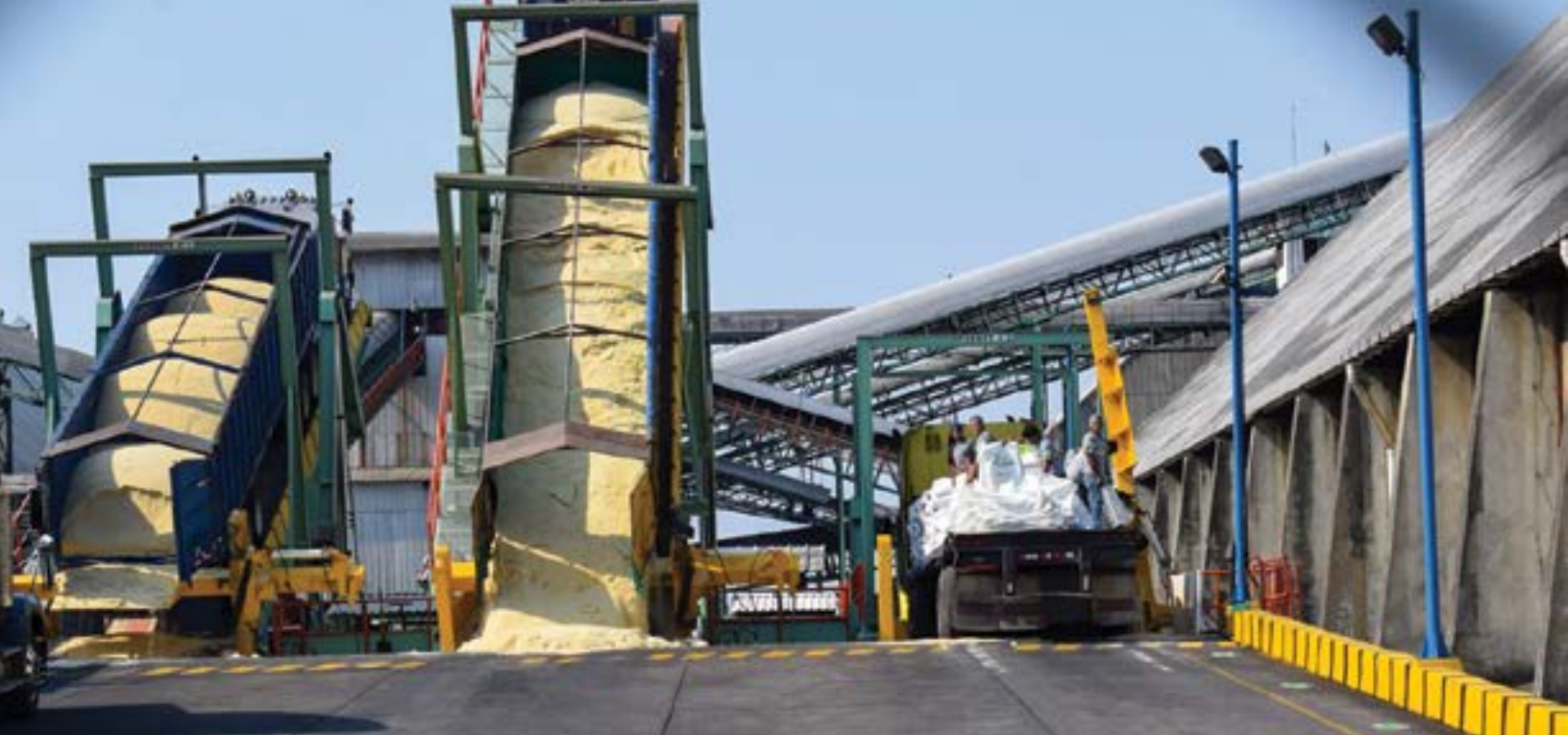
Terminal especializada de azúcar, descargando a través de bandas transportadoras del tráiler a 90 grados, directamente a las bodegas para la exportación
