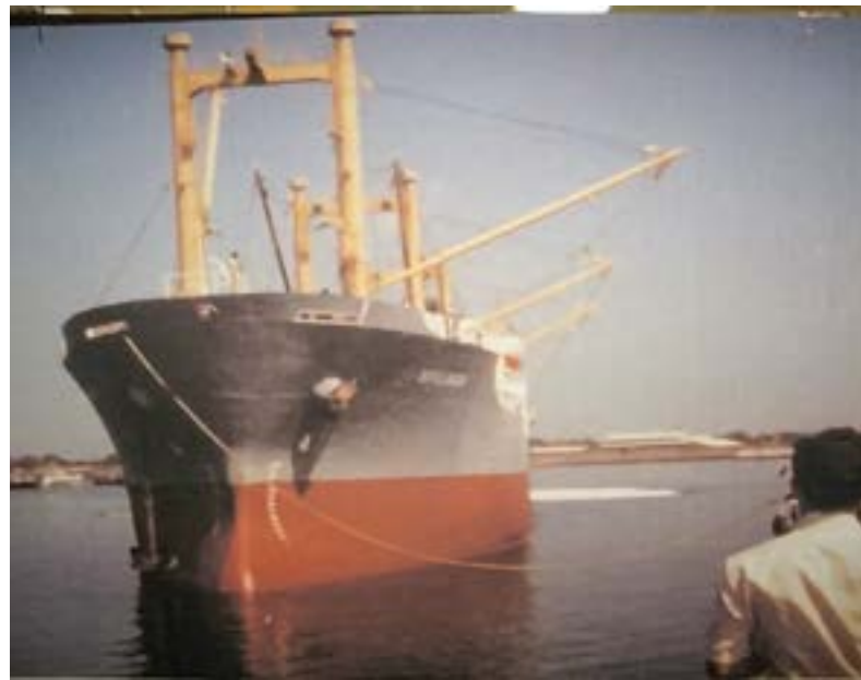
Atraque del Buque Spiliada el 19 de marzo de 1983, en el muelle comercial aún en construcción, en condiciones limitadas para iniciar las operaciones marítimo-portuarias.
