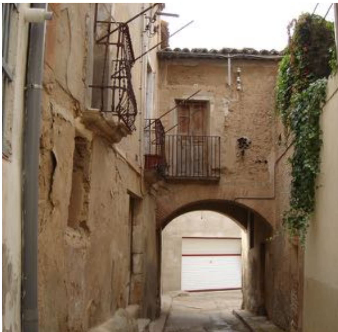
Carrer de Linyola (Pla d'Urgell), amb una casa construïda amb tàpia de principis del segle XIX.
