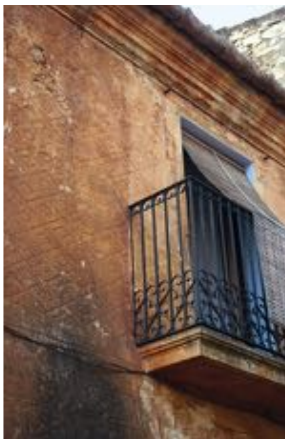
Façana tradicional de calç Font: Oriol Roselló
