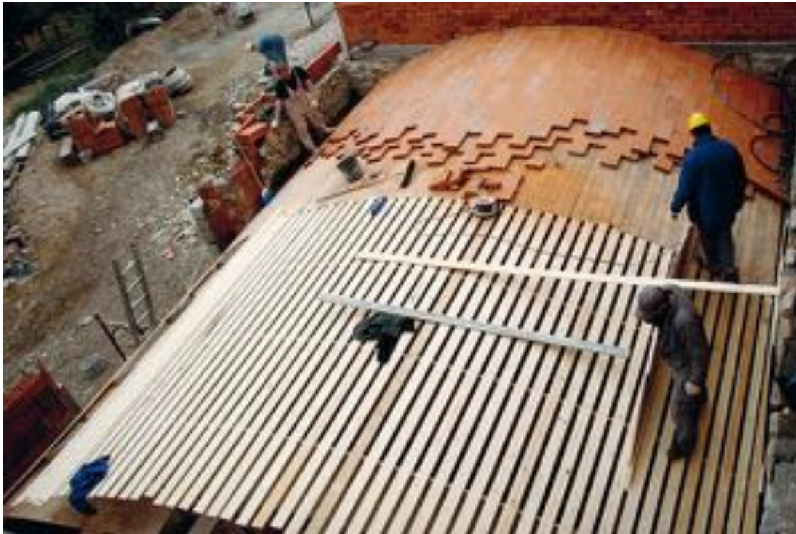
Encofrat d'una volta de maó pla Font: Oriol Roselló
