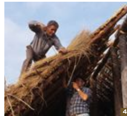
4. Barraquer i el seu ajudant cosint la borra de la coberta d'una barraca al delta de l'Ebre. Autor: Lázaro, ca. 1990 (MTT).
