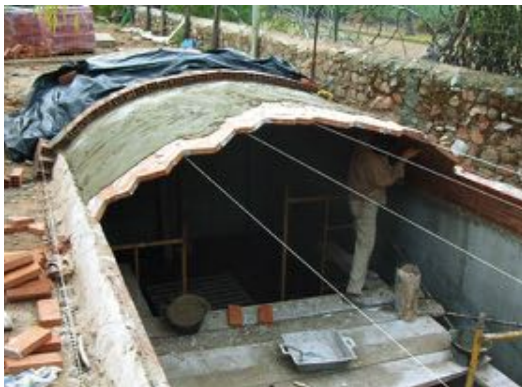
Procés d'execució d'una volta Font: Manuel Fortea
