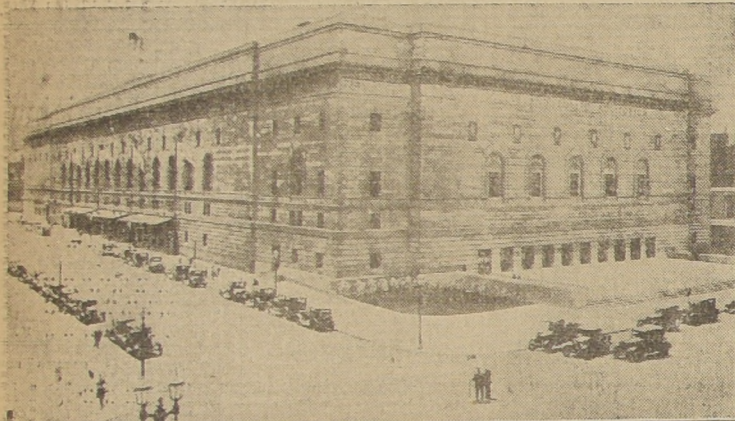
"Public Hall", en la ciudad de Cleveland, Estado de Michigan, es el lugar seleccionado para la convención del Partido Republicano, el 9 de junio próximo, para nominar sus candidatos presidenciales y vice presidenciales. El enorme edificio tiene cabida para 12.000 personas, y fué construido a un costo de $ 12.500.000, y fué allí donde Calvin Coolidge fué nominado en 1924. (Foto UNITED FEATURE SYNDICATE)
