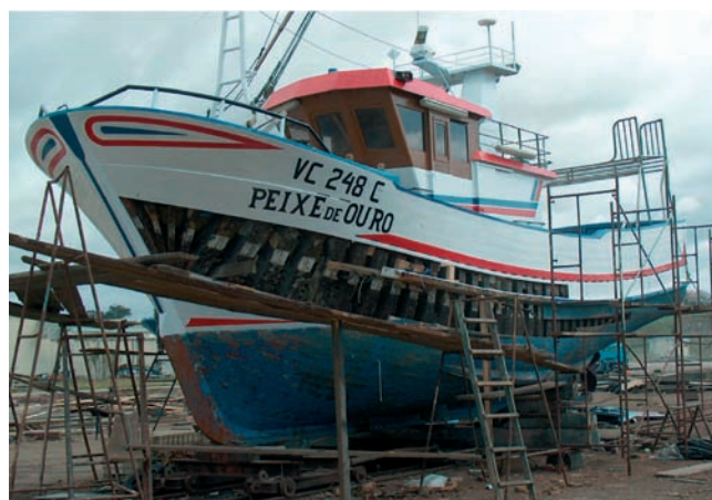
Estaleiro Sicnave Lda. Uma embarcação sendo reparada Abril de 2004
