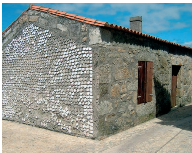
Detalle da fachada sur recuberta con testos
