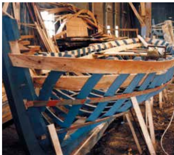
Buceta en proceso de construción
