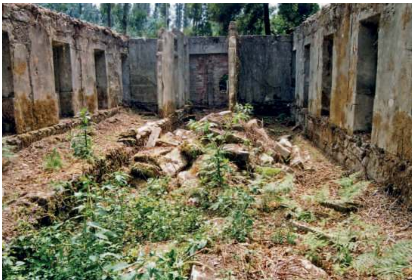
O interior do antigo edificio do lazareto
