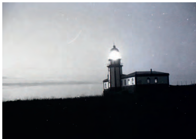
Faro da illa de Ons, 1989/ Foto Afonso
