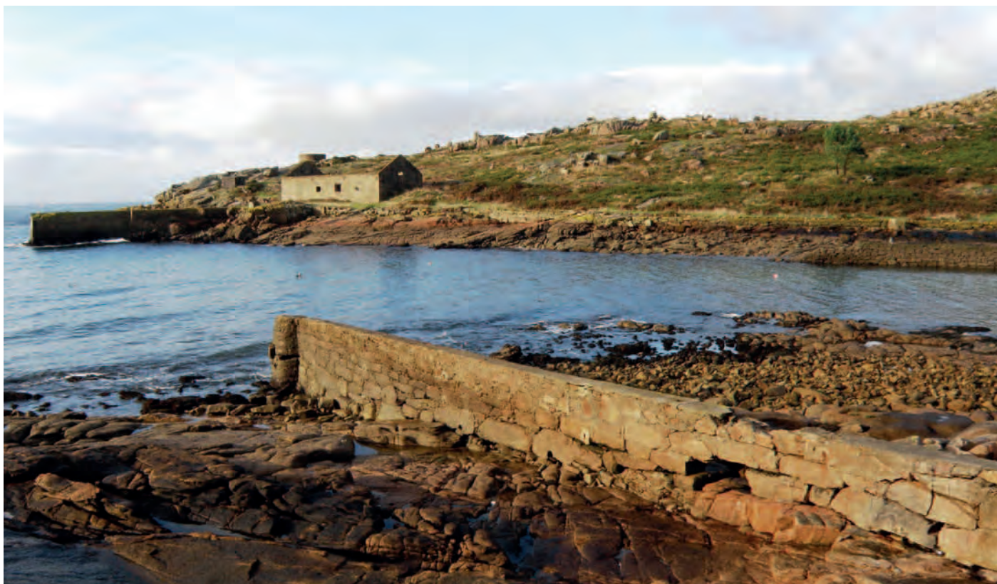
Caneliñas, protección da rampa de 1924
