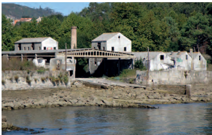
Instalacións no concello de Cangas
