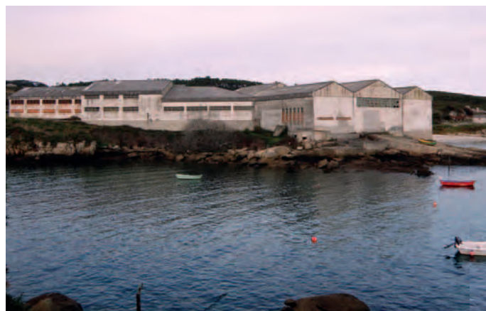
Instalacións de Morás
