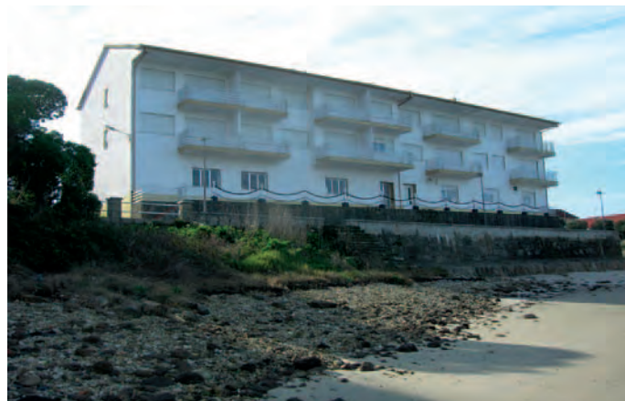
Edificación construída sobre a antiga salgadura de don Félix Batista
