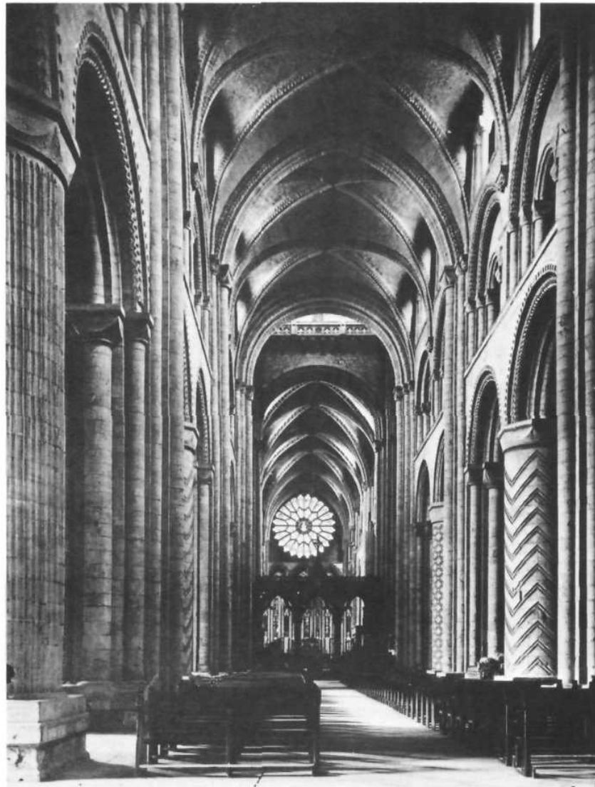
117. Um interior normando: a Catedral de Durham. Construída entre 1093 e 1128 (a abóbada foi completada mais tarde, de acordo com o traçado original)
