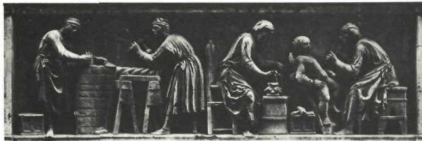
161. Pedreiros e escultores trabalhando em colocação de tijolo, perfuração, medição e escultura. Da base de um grupo por NANNI DI BANCO. Cerca de 1408. Florença, Igreja de Or San Michele
