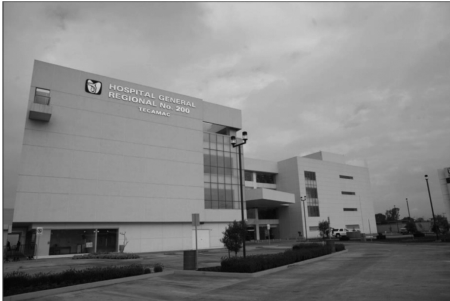
Figura 13–1. Hospital General Regional No. 200. Delegación Estado de México Oriente, IMSS. Unidad de segundo nivel de atención médica que cuenta con lo más avanzado en tecnología, y que es sede de campos clínicos de diferentes niveles educativos y carreras en el área de la salud.
