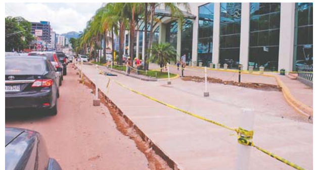
Desesperados, los capitalinos que transitan por la zona en sus automóviles, solicitan que los trabajos se agilicen.
