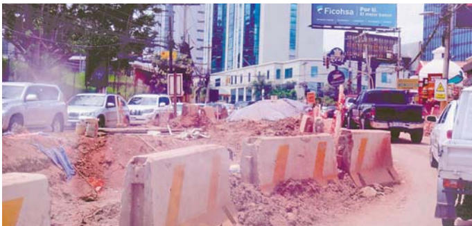
La instalación de nuevos acueductos en un tramo del bulevar Juan Pablo II ocasiona a diario tráfico vehicular.
