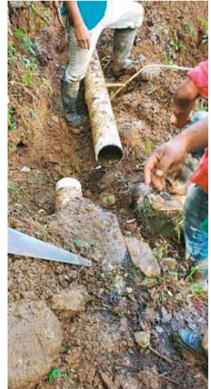
Empleados de Aguas de Marcala trabajan de manera continua para avanzar en las reparaciones.
