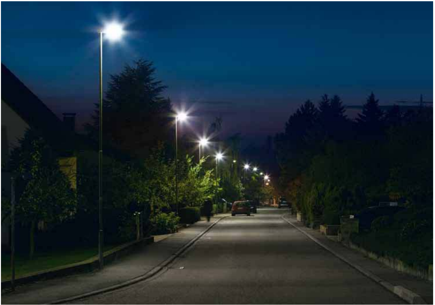
Die Schillerstraße in Kieselbronn vor der Sanierung.
