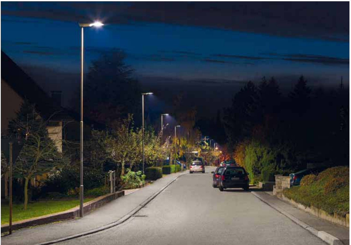
Die Schillerstraße nach der Sanierung mit SpeedStar Leuchten. Die gleichmäßige Ausleuchtung und die sehr gute Farbwiedergabe sorgen für mehr Sicherheit und Wohlbefinden.
