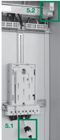
Bild 5: Zählerplatz mit Dreipunkt-Befestigung
