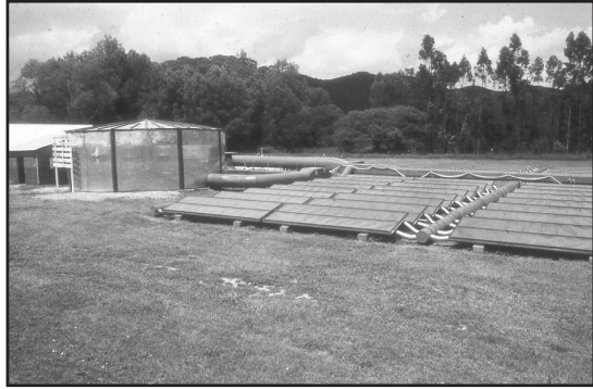
Figura 1. Secadero de tabaco en el INTA, Cerrillos, Salta.
