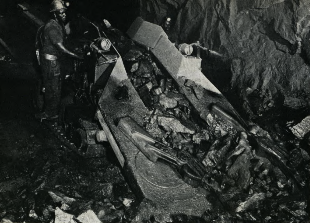
Ein Kapitel „US-Kohle“: Die Stahlgreifer des sogenannten „mechanischen Krokodils“ packen zu. Der Einsatz eines solchen leistungsfähigen Ladegerätes ist nur in mächtigen Flözen möglich.
