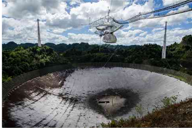
Rysunek 4.20 Radioteleskop o średnicy 305 m w obserwatorium Arecibo w Portoryko. Jest on wyłożony materiałem odbijającym i stanowi największą skupiającą zakrzywioną powierzchnię na świecie. Chociaż jego średnica D jest większa niż teleskopu Hubble’a, wykrywa on fale promieniowania o znacznie większej długości i jego dyfrakcyjna granica rozdzielczości zdecydowanie pogarsza się w porównaniu z przypadkiem teleskopu Hubble’a. Teleskop w Arecibo jest nadal bardzo przydatny, ponieważ niektóre ważne informacje o obiektach kosmicznych przekazywane falami radiowymi nie są przesyłane z wykorzystaniem światła widzialnego. Źródło: Jeff Hitchcock
