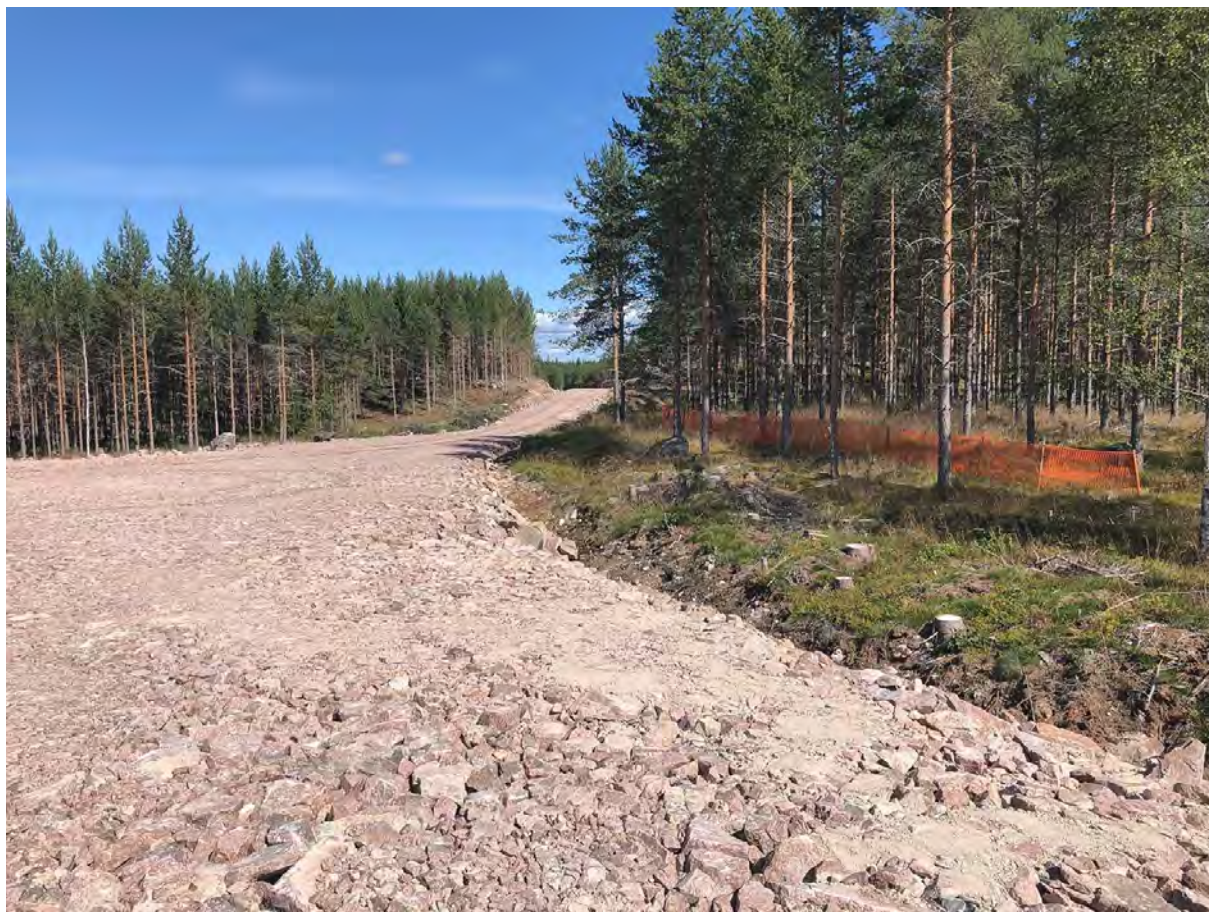
Figur 37. Exempel på utmärkning av fornlämning med orange staket. Foto från byggnation av Riskebo vindkraftspark, Hedemora kommun.
