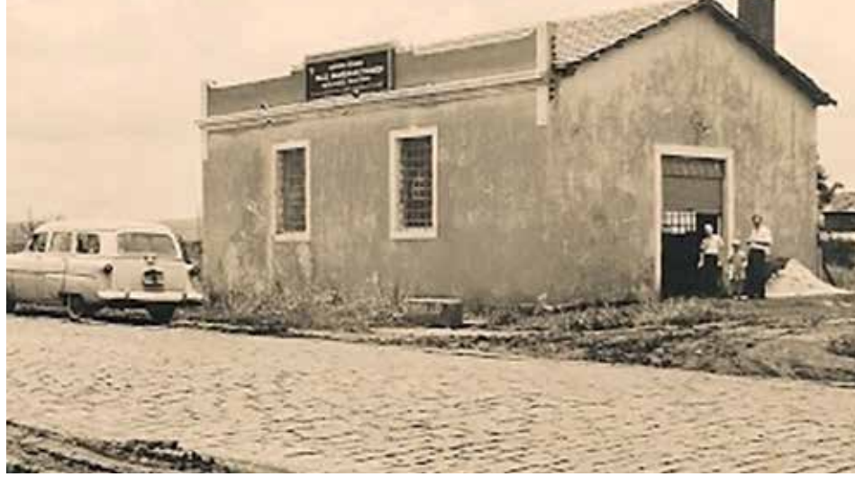
Palle Elétrica Jundiapéba building - old office
