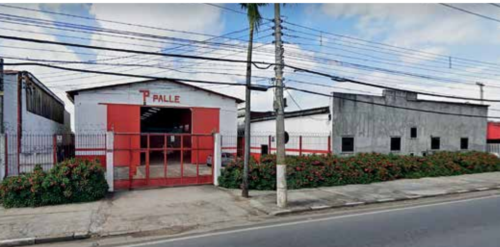
Palle Elétrica Jundiapéba building - new office
