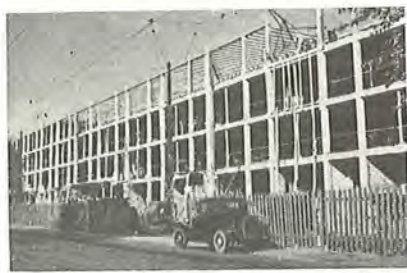
Kalltonskelet under opførelse med let kranmateriel.
