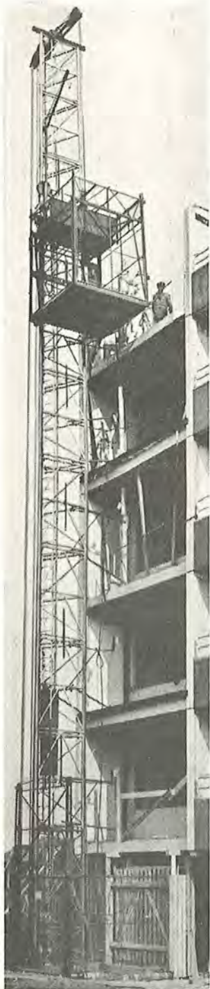
Fig. 52. De normale stilladstærne her i landet, må ikke benyttes til persontransport. Spørgsmålet er blevet aktuelt i de sidste år, hvor der bygges huse med 10-14 etager. På billedet ses den første personelevator, der er installeret på en byggeplads her i landet. Den er forsynet med særlige sikkerhedsanordninger, der ikke er helt billige. Dens kapacitet er 10 mand eller 1850 kg. (AAB's højhus Rodovre, se fig. 154 og 155).
