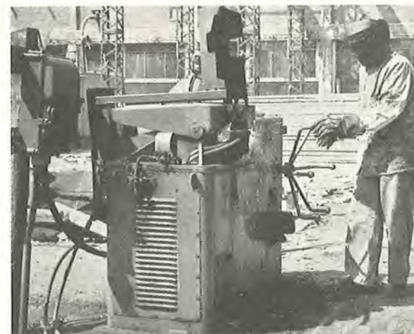
Fig. 73. Svejsemaskine til sammensvejsning af rundjern i brug på arbejdsplads.
