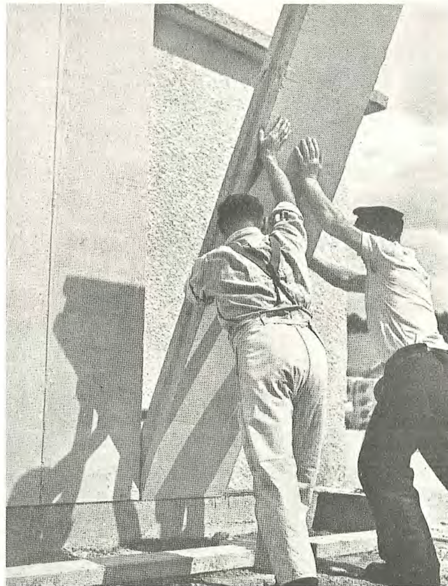
Fig. 141. Etagehøjt element udført af letbeton. (System Hebel, tysk byggeplads).
