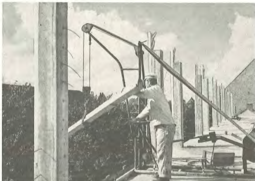
Fig. 54. En etagekran som denne (Gecko) er forholdsvis let at flytte rundt langs en etageadskillelses periferi. Den kan bruges til opbejlsning af byrder på indtil 400 kg. Motoren, som skimtes til højre, fungerer som kontravægt.
