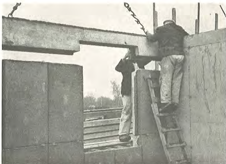
Fig. 138. Vinduesoverligger monteres. Bagvæggens overflade er støbt med fint leca-grus, og efter udspartling af fugerne kan den direkte bruges som underlag for tapet.
