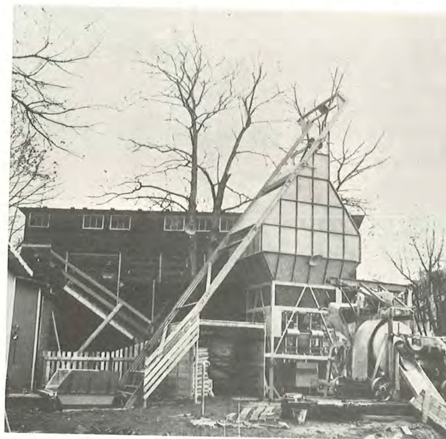
Fig. 70. Automatiske vejeanlæg er ikke billige, men de sparer megen tid og er nu i gang på en mængde byggepladser. Vejeanlæggets automatik er placeret lige under siloerne. Tilslagsmaterialer tippes fra lastvognen ud i en beholder, som er forsænket i en grube i jorden til venstre. Ad skinnerne kører beholderen op og tommer sit indhold ned i siloerne.
