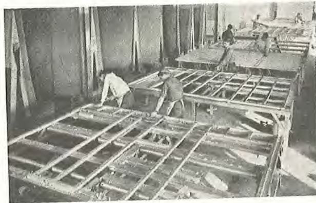
Fig. 12. Den ser ikke udviklet ud denne vægfabrikation på samlebånd. — Men planlægningen og organisationen er forbilledlig, vægge til et halvt hundrede komplette huse bliver hvert dogn til på en sådan fabrikkationslinie.
