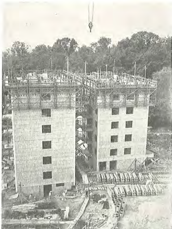
Fig. 130. Betonvæggene støbes op i en glideform, som hæves af donkræfte, der dirigeres af en olietrykspumpe. En arbejdsplatform, der dækker hele bygningen, er knyttet til systemet. (Punktbus Bellahøj. Entreprenør: Christiani og Nielsen. Arkitekt: Eske Kristensen. Rådgivende ingeniør: Birch og Krøgeboe).
