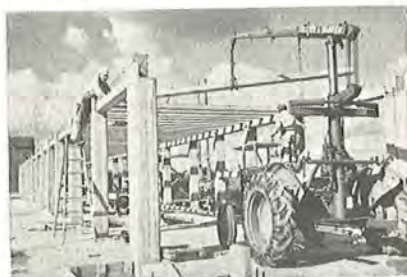
Traktorkran oplægger bjælker på dragerne.
