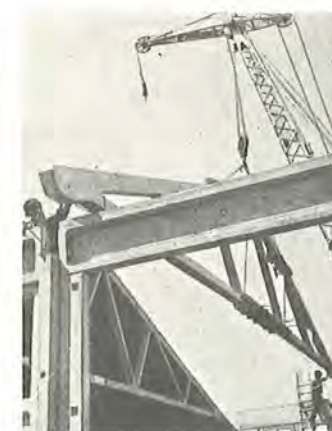
Montage af CHOKBETON-gitterspærfer, spændvidde 15 m.
