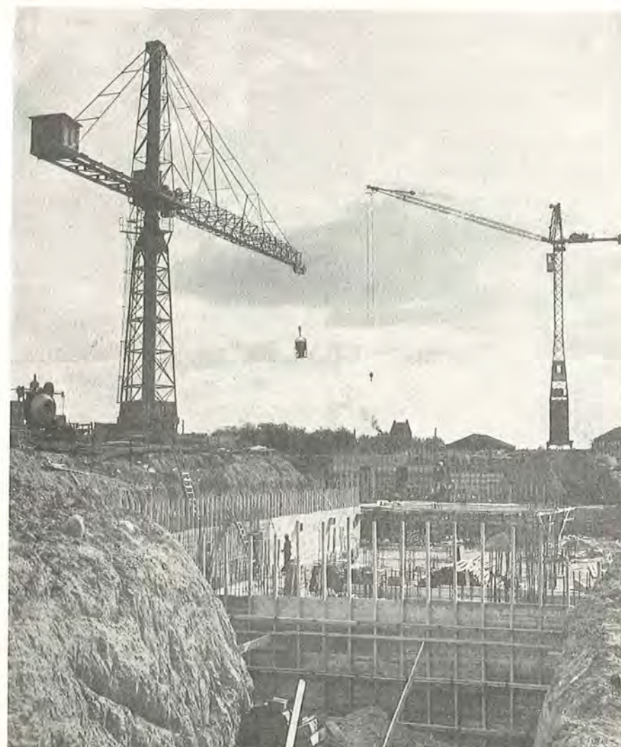
Fig. 29. Til højre: Stor tårnkran af fabrikat Wolff. Udliggeren kan indstilles i en vilkårlig vinkel med horisontalplanen. I vandret stilling er udliggeren hævet 31 m over terrænet. Den kan da nå ind over et 10-etages hus med en byrde på 1200 kg. Naar udliggeren er anbragt i sin overste stilling, med en hældning på 60°, kan kranen placere en byrde på 3000 kg i et 50 m højt hus.
