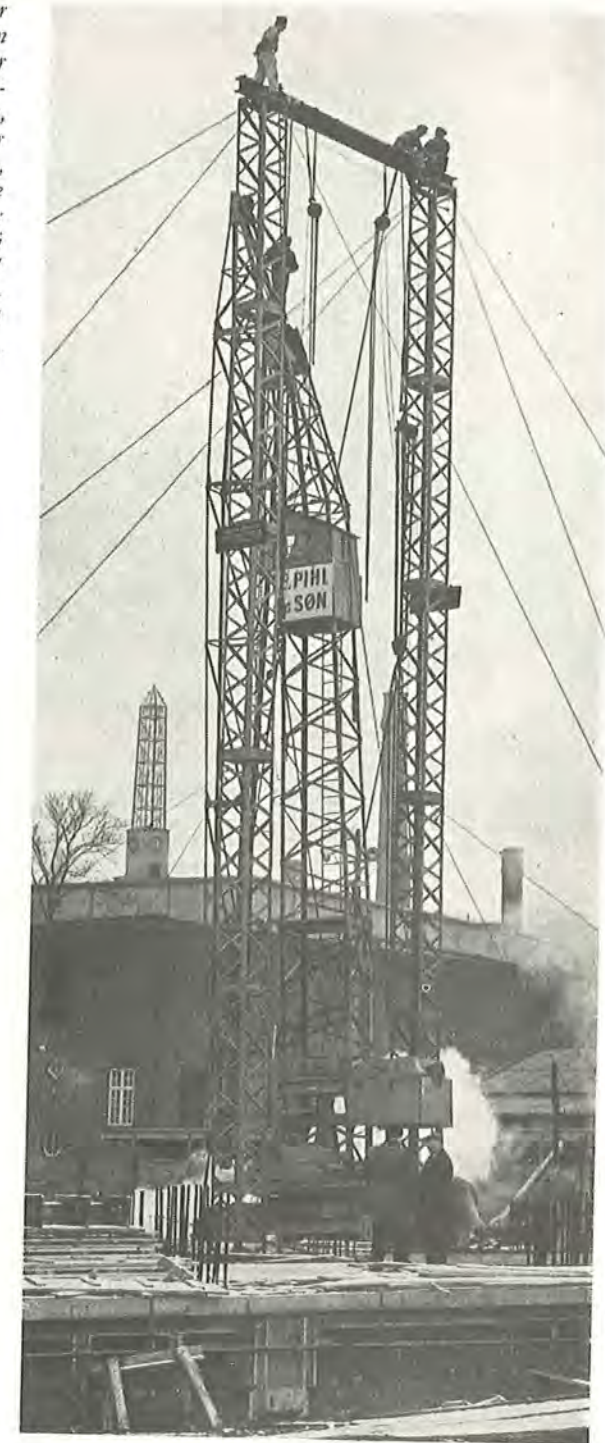
Fig. 36. Gitterportalen har netop hejst tårnkranen en etage op. Tårnkranens spor løber på selve etageadskillelsen. I en boligbebyggelse, som kun dimensioneres for 200 kg/m 2 nyttebelastning, kunne dækket ikke bære kranen, hvis egenvægt er 19 t. Nyttebelastningen i denne bygning er 1000 kg/m 2 . (Aftapningshal Carlsberg, Entreprenør: E. Pihl og Son. Projekt: Carlsberg).
