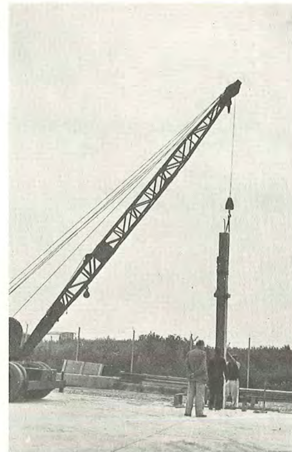
Fig. 93. Montering af søjler i den på fig. 92 viste bygning.
