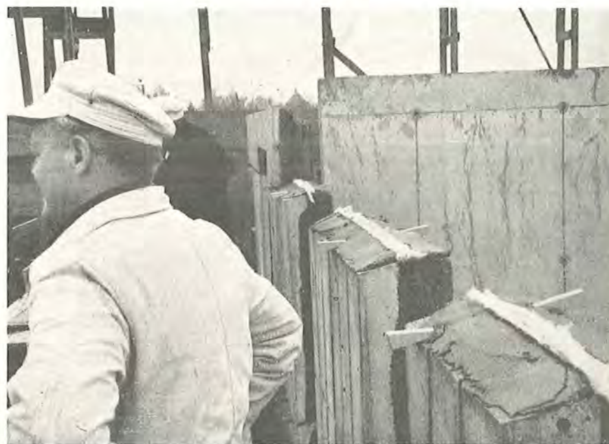
Fig. 137. Sammenstøbning af små ydervægselementer med betonforstøbning og leca-beton i bagvæggen. Mørtelfugen er delt med en glasuldstrimmel for at bryde fugens kuldebro.
