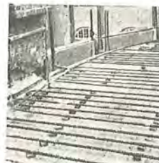
Varmeslanger udlagt på for-skalling inden indstøbning.
