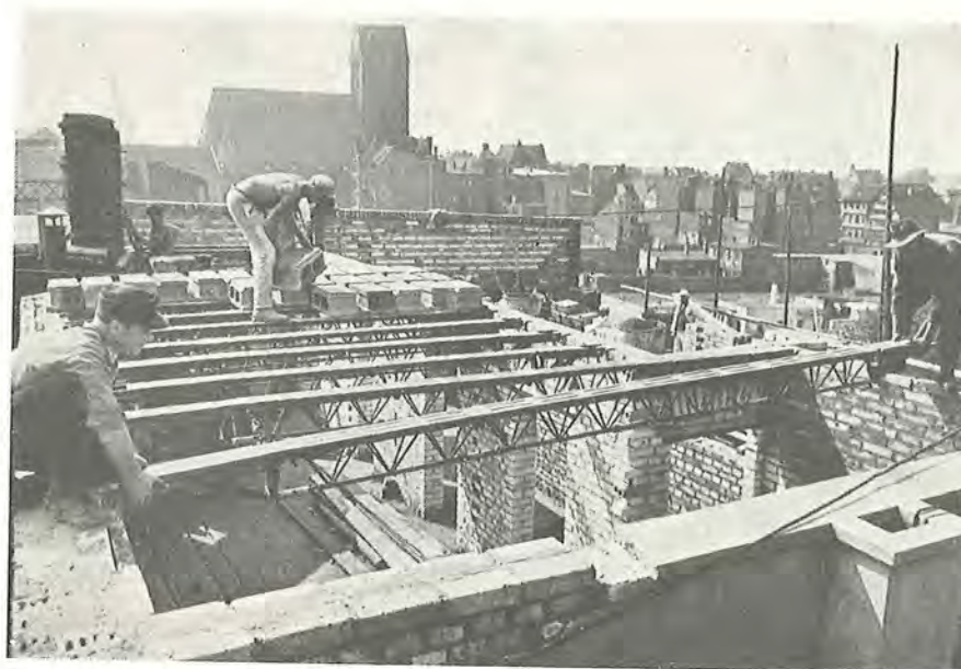
Fig. 177. Forskallingsdragere anbringes. (System Hico).
