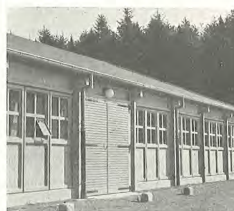
Standardbygningstype til magasiner, garager, værksteder og lign., opført af CHOKBETON-vægplader, -søjler og -gitterspærfer.
