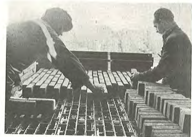
Fig. 151. Murstenene anbringes i et støbejernsgitter, hvis risteværk svarer til forbandtet; derefter hældes der mørtel ud i formen, og der vibreres, indtil fugerne er fyldte.
