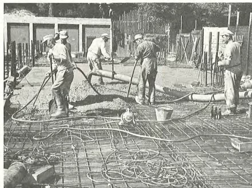
Fig. 48. Pumpeledningens munding kan let flyttes omkring på udstøbningsstedet. Den i forrige figur viste betonpumpe kan presse beton gennem pumpeledningen, diameter 15 cm, over en 300 m lang, vandret strækning. I lodret retning kan den presse betonen 30 m op. (Samme byggeplads som på fig. 36).
