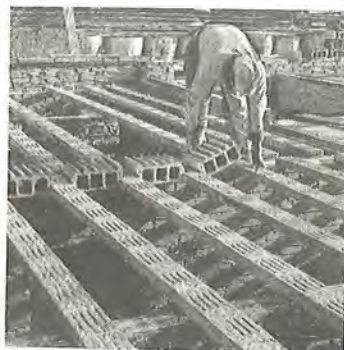
Ståltegldek under oplægning.
