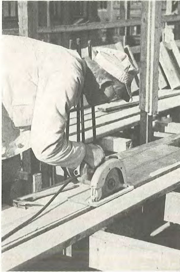
Fig. 76. En lille elektrisk håndrundsav er bekvem at arbejde med på et stillads.
