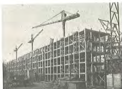
Kalltonskelet under opførelse med svært kranmateriel.
