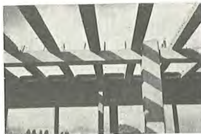
Dækblokke oplægges mellem bjælkeelementerne.
