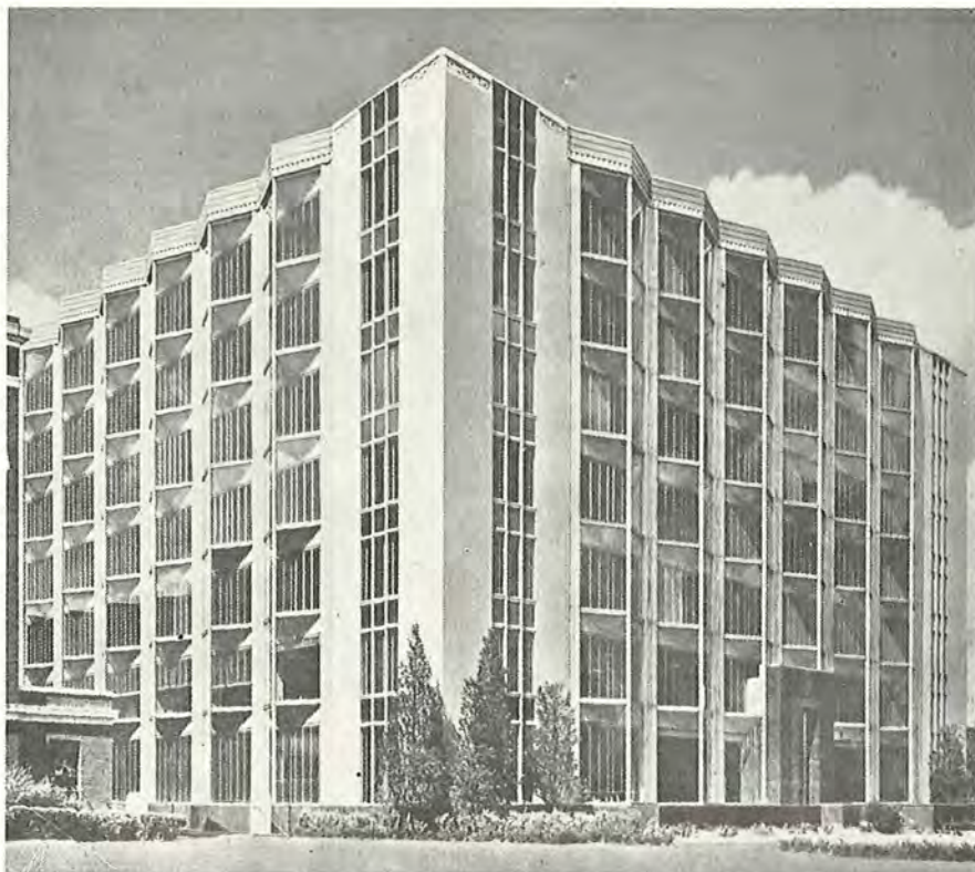
Fig. 111. Heller ikke i denne bygning er den bærende konstruktion af aluminium. Men beklædningen af skeletkonstruktionen er udført i dette uforgængelige metal. (Laboratorie- og kontorbygning, Wisconsin, U.S.A.).
