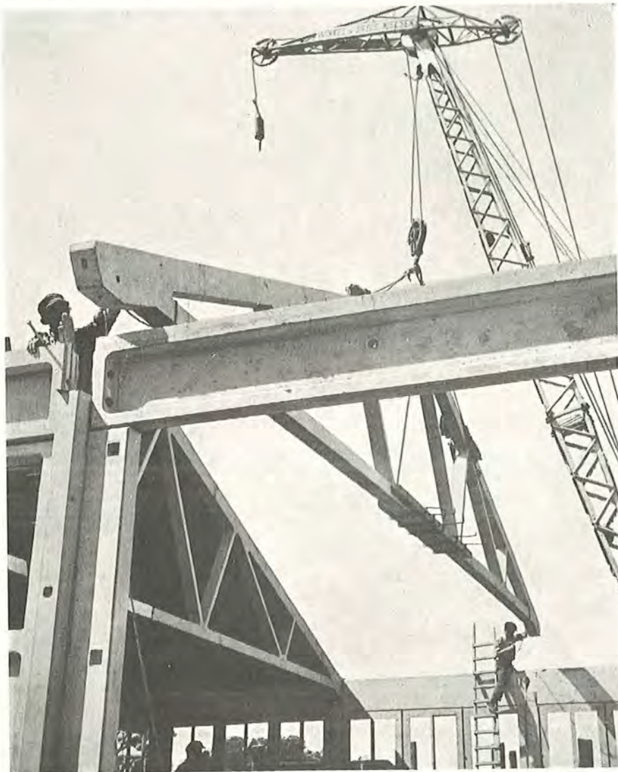
Fig. 103. Chokbetonelementer samlet og låst med bolte og med fjer og not. Se næste figur. Så glatte betonflader finder man normalt kun på industrielt fremstillede elementer.
