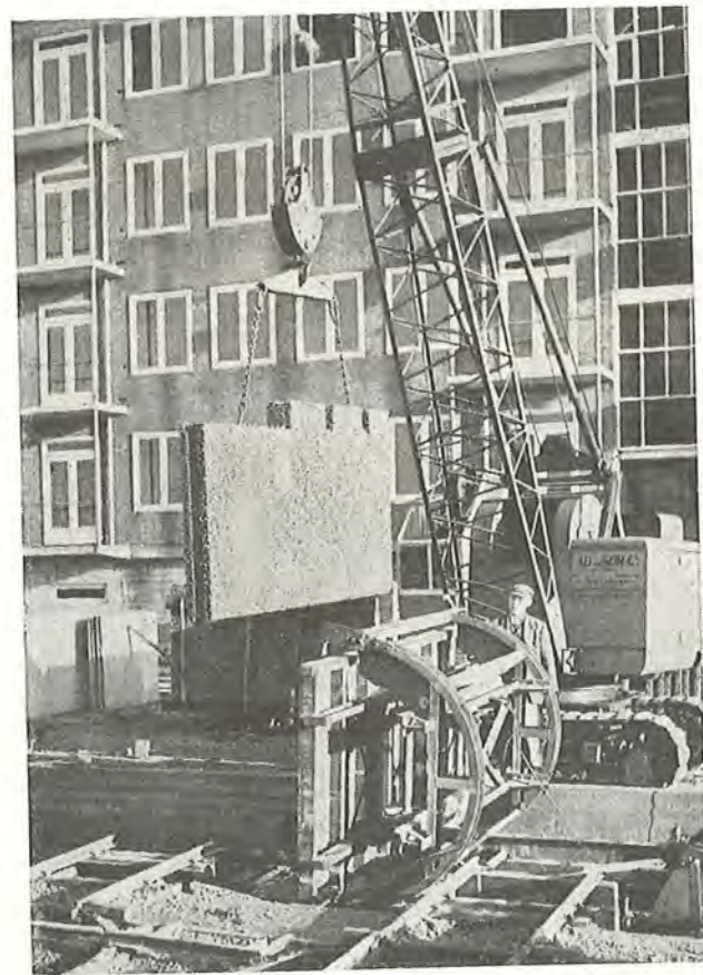
Fig. 153. For at undgå bøjningsspændinger i elementet, der ikke er egnet til at optage store trækspændinger, er hele støbeflagen anbragt på en skinnevogn, som kan vippe 90°, således at elementet blidt bliver anbragt på højkant.
