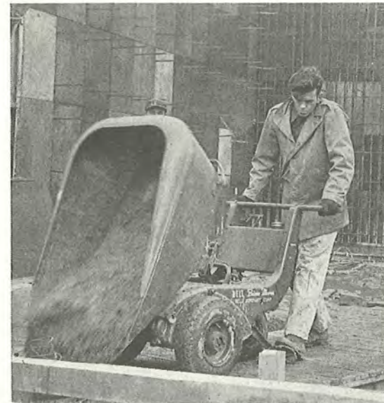
Fig. 59. Denne betonbør skal blot styres, drivkraften leveres af en lille motor.
