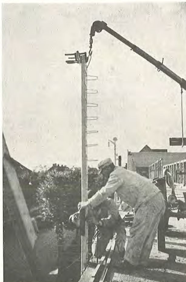
Fig. 85. Kaltonsojleside fastspændes på den tilsvarende opragende side fra forrige etage. Herefter kan denne søjledele tjene som afstivning for den modstående søjleside og for de forskallingsbrædder, som lukker spalten mellem de to elementer. På fig. 54 ses en række færdige søjler.
