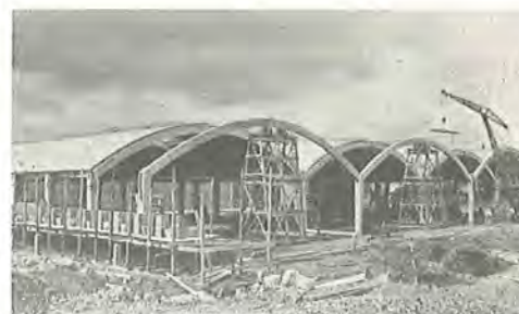
CHOKBETON-buer med 20 m spændvidde.
