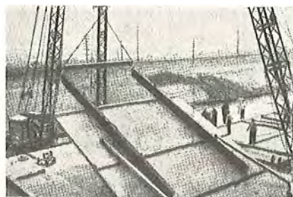
Fig. 136. Dette er sikkert den største tilt-up væg, som kan fremvises. Væggen vejer 35 t. (Byggeplads i U.S.A.).
