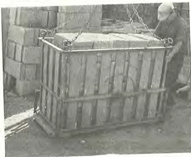
Fig. 42. Kurv til krantransport; det tager mange mand mange gange længere tid at bringe disse sten op på deres ryg. Men det er ikke så forfærdelig længe siden, at ryg-metoden var en selvfølge.
