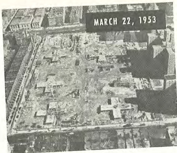
Fig. 17. Hver eneste søjle og bjælke, hver eneste plade er støbt på stedet. Men pladsen er betjent af store mobilkraner som kan række ind over øverste dæk i de 14 etagers buse. Den traditionelt opbyggede konstruktion er det på denne måde lykkedes at få i vejret på forbausende kort tid. Hurtigere kunne det næppe gøres med selv det mest udspekulerede elementbyggeri.
