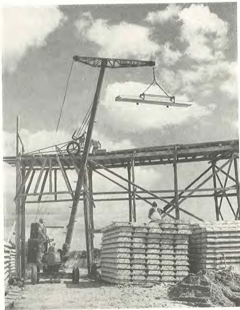
Fig. 39. Nealkran under oplægning af lette tagplader. Dens løfteevne er 400 kg. (Busbal, Arbus. Entreprenør: Wright, Thomsen & Kier).
