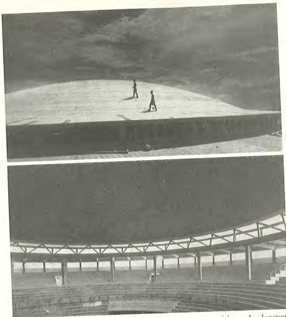
Fig. 9. Ny erkendelse inden for ingeniørvidenskaben har fremelsket andre konstruktionsmuligheder end den gængse plade-bjælke-sojle opbygning. Denne jernbetonskål, som har en diameter på 50 m, er kun 8 cm tyk. Et spinkelt system af jernbetonbjælker og -sojler bærer hele konstruktionen. (Christiani & Nielsen: Boksestadion i Bangkok).
