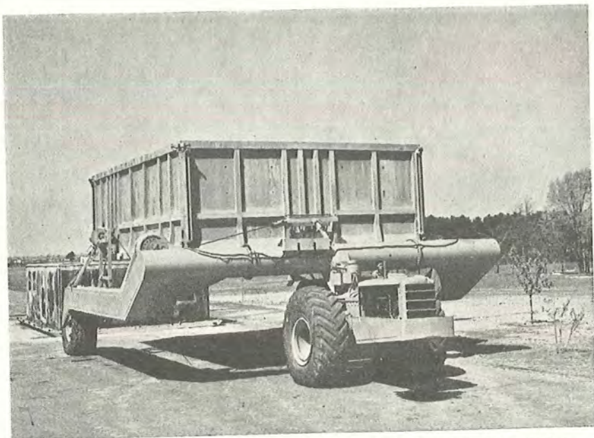
Fig. 66. Specialvogn til transport af forskallingsenbed til et helt enfamiliebus. Det er et stort køretøj, som det fremgår ved sammenligning med føreren. (U.S.A.-byggeplads).
