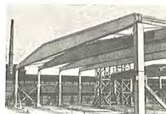
Strengbetondragere, standardtype SIB 30/156, spændv. 31,4 m, ringovnsbygn.
