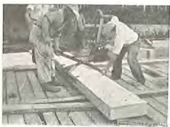
Aflæsning af Gasbetonplader på byggeplads
