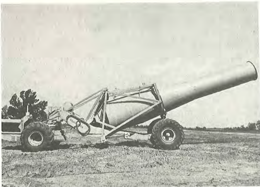
Fig. 49. En modificeret betonpumpe med en kun 6 m lang »pumpeledning«. Men til gengæld er hele aggregatet mobilt. (U.S.A.-byggeplads).
