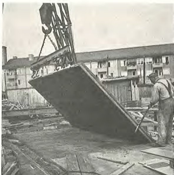
Fig. 43. Transport af denne 4-5 t tunge indvendige væg er en virkelig kranoperation. Se fig. 37.
