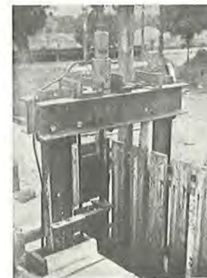
Fig. 131. Detalje fra glideforskallingen: Stålgalgen er fastgjort til donkraften, der ses i midten over galgens overligger, og som omslutter en rundjernsstang, der er fastgjort i den støbte del af væggen. Til stålgalgen er både forskalling og platform fæstnet.
