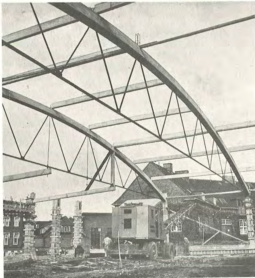
Fig. 106. 36 m tagdragere i kombineret stål og beton. Fod og gitterstænger, som består af rundjern, er udført i 2 halvdele på et svejseværksted. Bøen er støbt på stedet. (Rutebilgarage for statsbanerne, Århus. Entreprenør: Ejner Mikkelsen. Rådgivende ingeniør: Rambøll og Hannemann).
