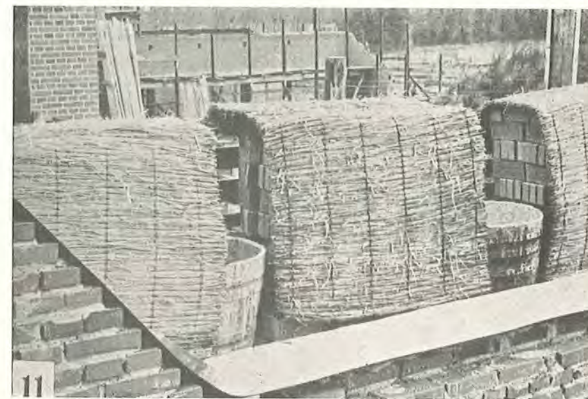
Fig. 25. Når murstensstaberne tildækkes med halmmåtter og murværket med tagpap, behøver mureren ikke at blive hjemme efter første nattefrost eller lette snefald.
