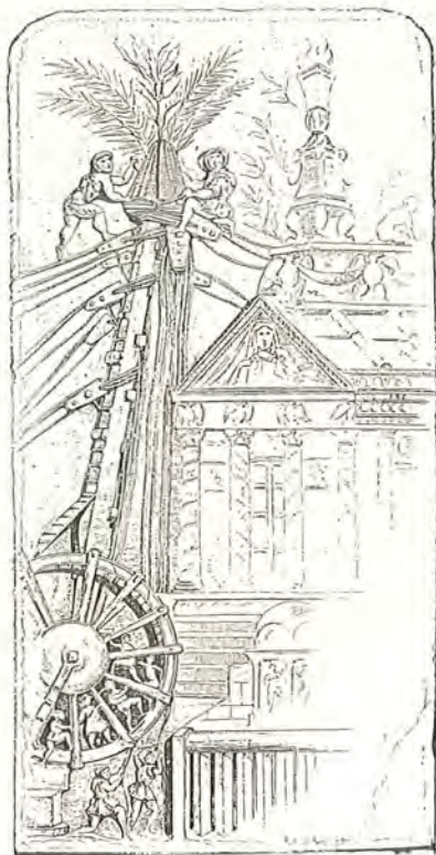
Fig. 26. En kran på en byggeplads er ikke en snedig nutidsopfindelse som så mange andre transportapparater. Her er en gengivelse af et berømt relief, der nu befinder sig i Lateranmusæet. Det stammer fra den romerske kejsertid.
