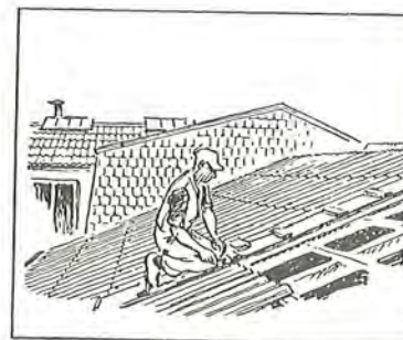
Oplægning af ETERNIT bølgeplader
