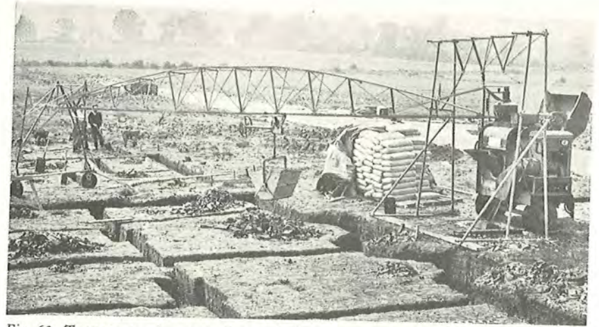
Fig. 63. Transportør benyttet til grundudstøbning. (Engelsk byggeplads).
