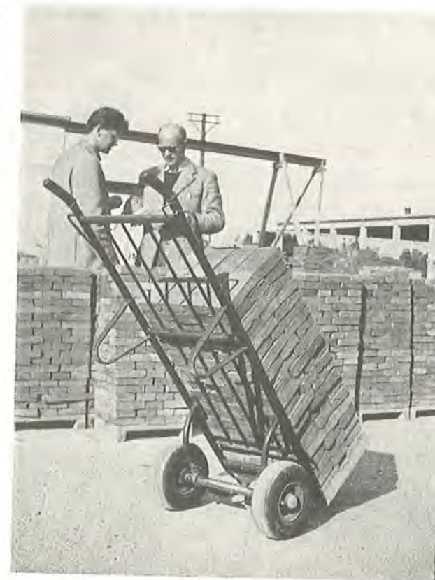
Fig. 56. En murstens-kærre er ikke nogen vidtgående mekaniseringsforanstaltning. — Men den repræsenterer alligevel et væsentligt fremskridt. Det er ikke længe siden, at man foretrak at bære stenene.
