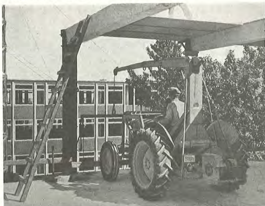
Fig. 50. Traktorer, der hidtil hovedsagelig har været forbeholdt landbruget, er begyndt at indjinde sig på vore byggepladser. Den viste traktor vejer 1300 kg og arbejder her på et dæk beregnet til en nyttelast på 400 kg/cm 2 . Se fig. 88.
