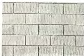
Murværk af Gasbetonsten
