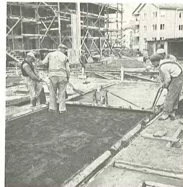
Fig. 145. De største vægge er 2,65×6,00 m. De transporteres af portalkranen (fig. 37) direkte fra støbestedet til deres plads i huset.
