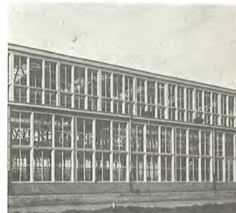
CHOKBETON-vindueselementer danner facade i fabriksbygning.
